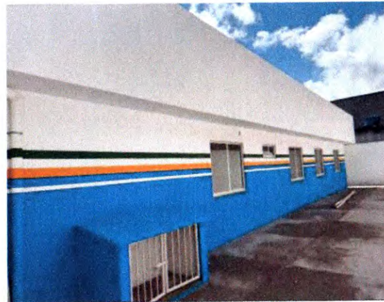
PINTURA EXTERNA E GRADES
