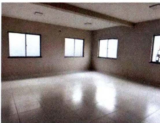
PINTURA DE INTERIORES E INSTALAÇÕES ELÉTRICAS
