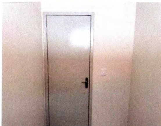
PINTURA DE INTERIORES E INSTALAÇÕES ELÉTRICAS
