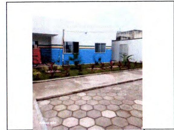
PINTURA EXTERNA, PISO EM ALTA RESISTÊNCIA, GRAMA E PAISAGISMO
