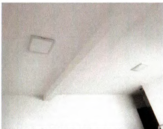
PINTURA DE INTERIORES E INSTALAÇÕES ELÉTRICAS
