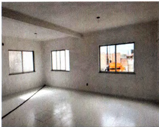
INSTALAÇÕES ELÉTRICAS E SELADOR
