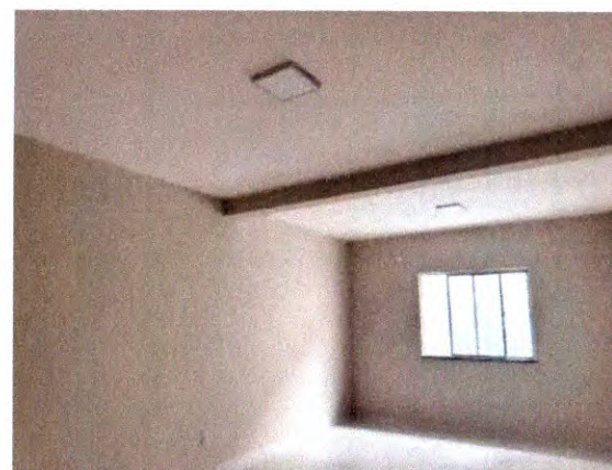
PINTURA DE INTERIORES E INSTALAÇÕES ELÉTRICAS
