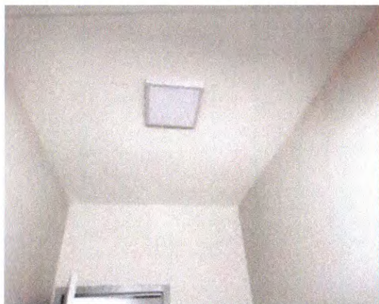
PINTURA DE INTERIORES E INSTALAÇÕES ELÉTRICAS
