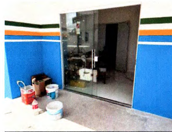
PORTA EM VIDRO, PISO DE ALTA RESISTÊNCIA E PINTURA EXTERNA
