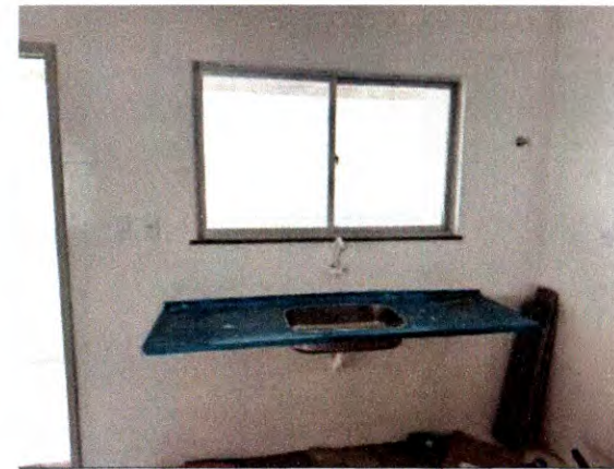
PIA INOX, ACESSÓRIOS E INSTALAÇÕES ELÉTRICAS
