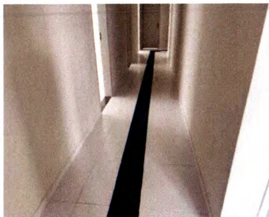
PISO TÁTIL E PINTURA DE INTERIORES
