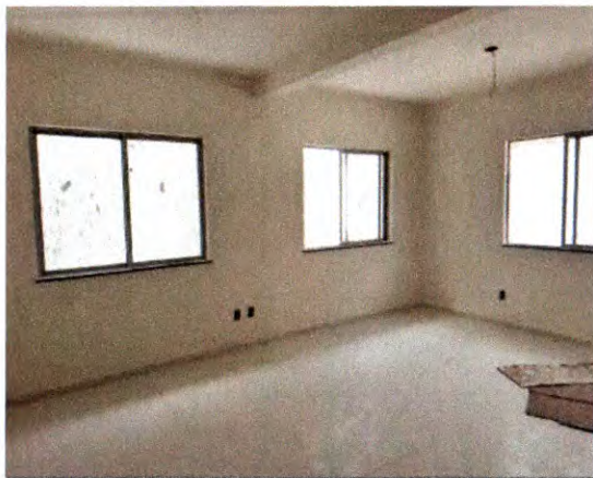
PINTURA DE INTERIORES E INSTALAÇÕES ELÉTRICAS
