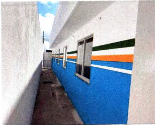
PINTURA EXTERNA E GRADES
