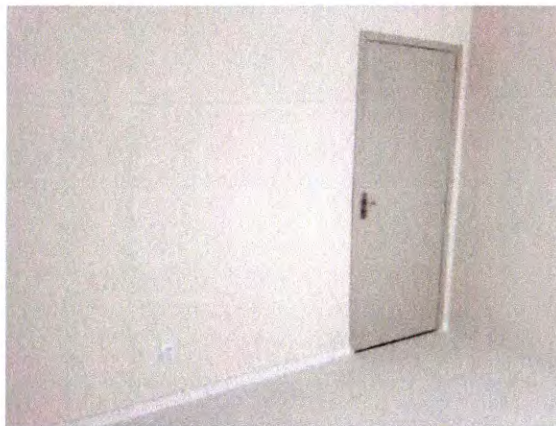
PINTURA DE INTERIORES E INSTALAÇÕES ELÉTRICAS
