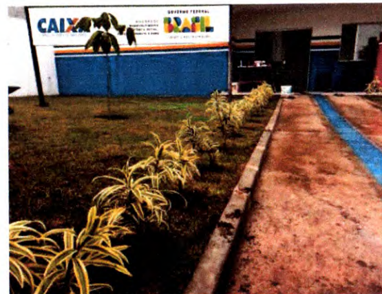
PINTURA EXTERNA, PISO EM ALTA RESISTÊNCIA, GRAMA E PAISAGISMO
