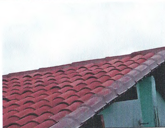
TELHAMENTO CERÂMICO; EMASSAMENTO DE BEIRAL E CUMEEIRA
