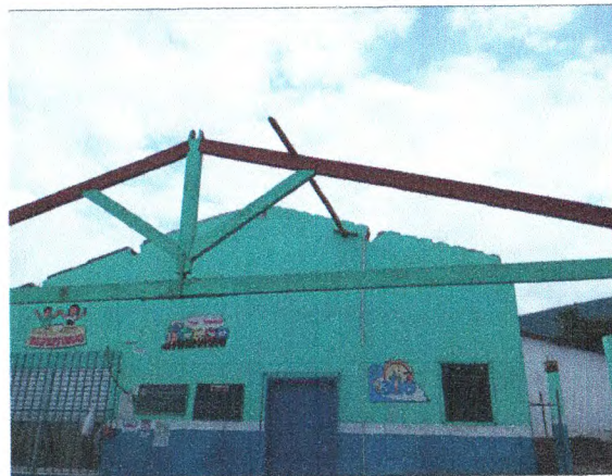
REMOÇÃO DE PEÇAS DE MADEIRA; RECUPERAÇÃO DE TESOURA
