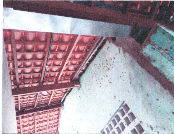
CALHA EM CHAPA DE AÇO GALVANIZADO; PEÇAS EM MASSARANDUBA; COMBOGÓ DE CIMENTO
