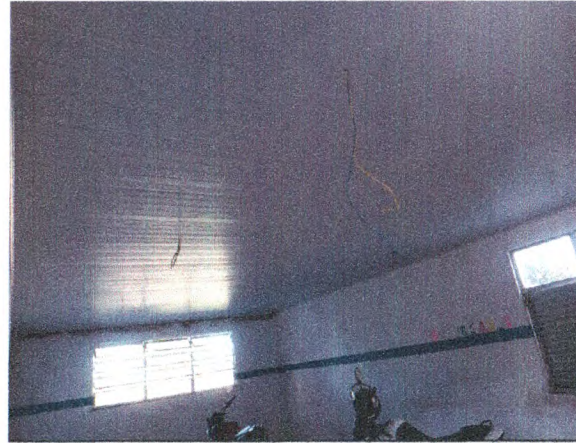
REFORMA - FORRO DE PVC; INSTALAÇÃO ELÉTRICA
