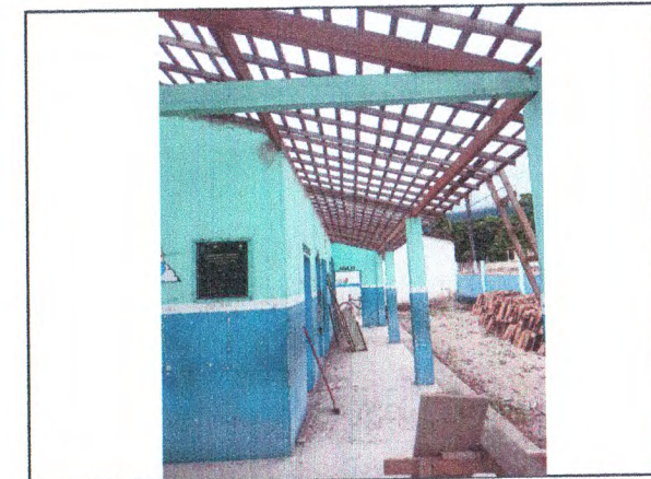
REVISÃO DE COBERTURA; MADEIRAMENTO EM MASSARANDUBA; RECUPERAÇÃO DE TESOURA
