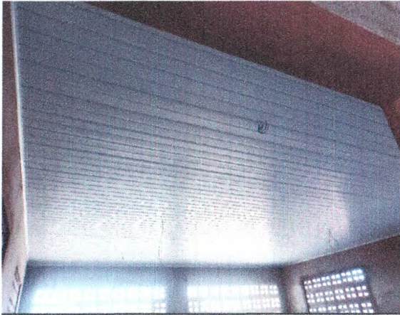
AMPLIAÇÃO - FORRO DE PVC; INSTALAÇÃO ELÉTRICA; COMBOGÓ DE CIMENTO
