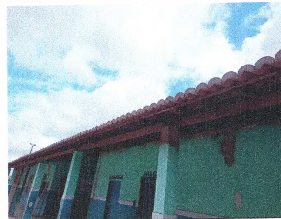
TELHAMENTO CERÂMICO; MADEIRAMENTO EM MASSARANDUBA; EMASSAMENTO DE BEIRAL
