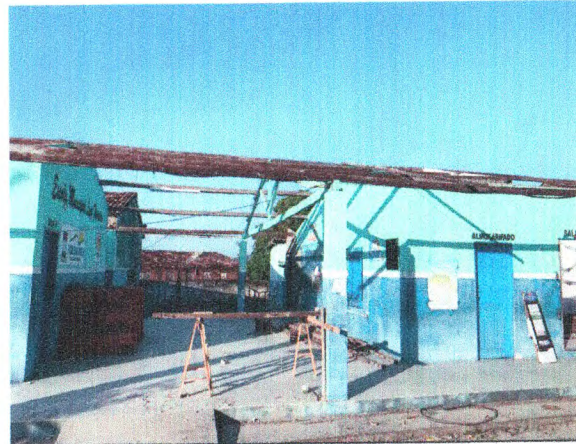
REMOÇÃO DE PEÇAS DE MADEIRA
