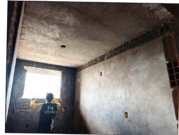
REBOCO PAREDE E TETO
