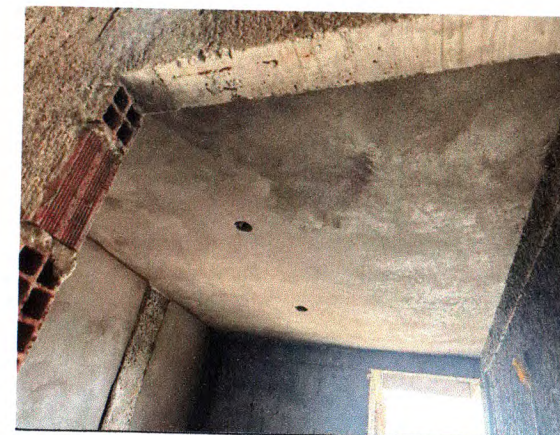
REBOCO TETO E PAREDE
