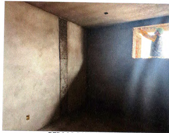
REBOCO PAREDE E TETO
