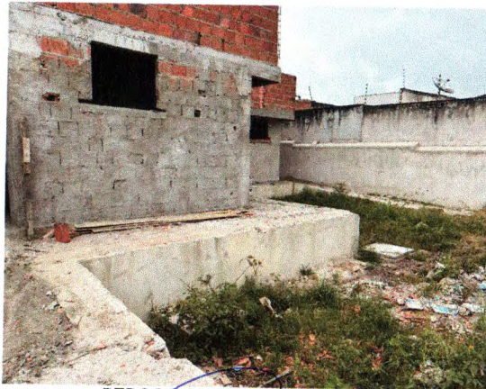
REBOCO ALVENARIA DE PEDRA
