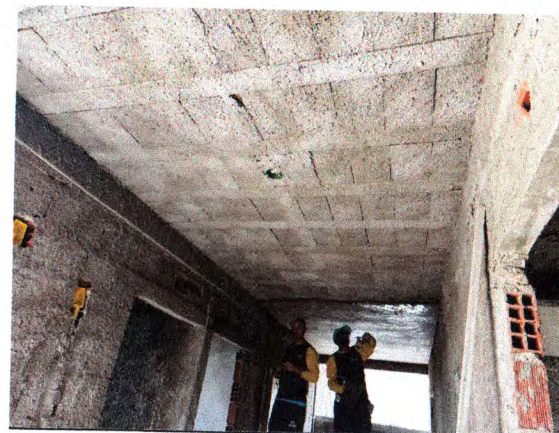
REBOCO E CHAPISCO TETO
