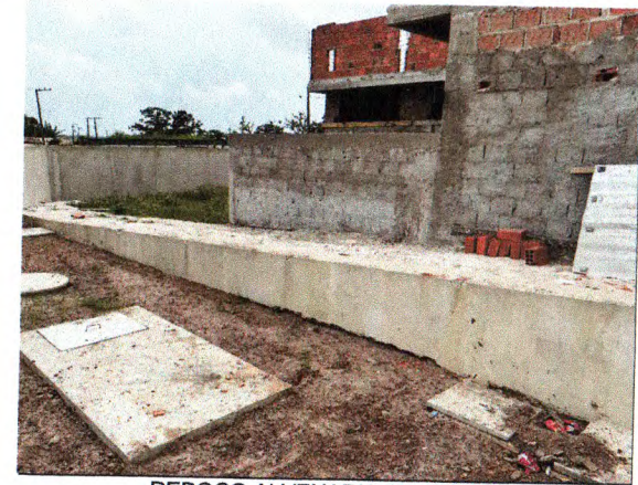
REBOCO ALVENARIA DE PEDRA
