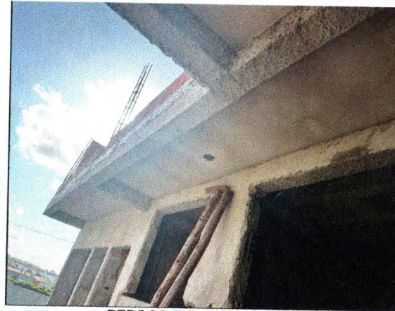
REBOCO EXTERNO E TETO
