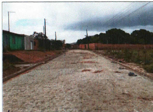
PAVIMENTAÇÃO DO TRECHO 01
