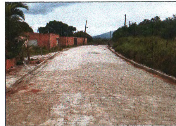
PAVIMENTAÇÃO DO TRECHO 01
