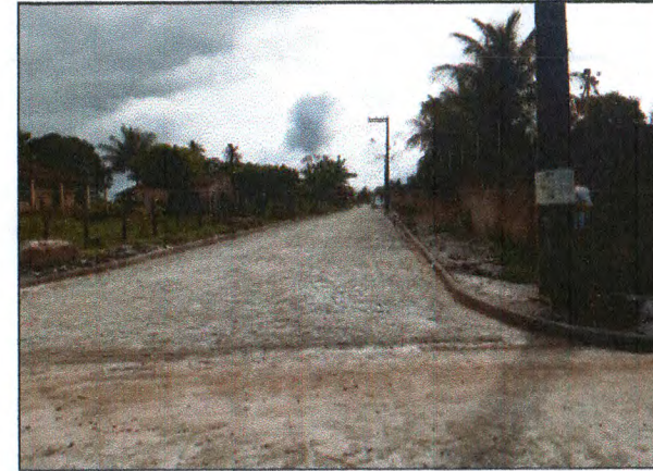
PAVIMENTAÇÃO DA RUA DA PAZ
