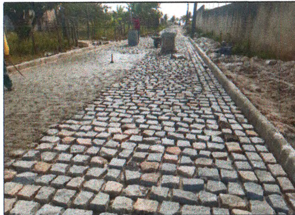
PAVIMENTAÇÃO DA RUA DA PAZ
