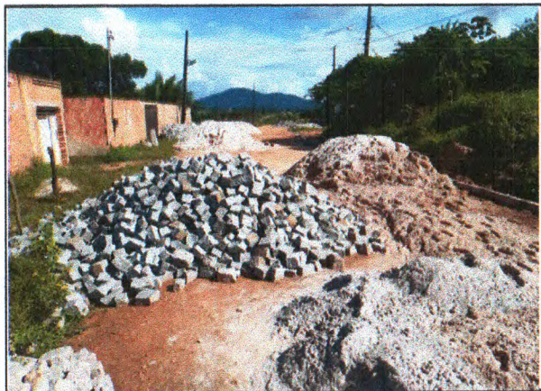
PAVIMENTAÇÃO DO TRECHO 01
