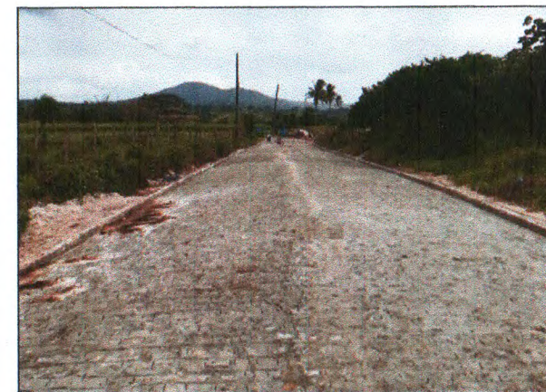
PAVIMENTAÇÃO DO TRECHO 01
