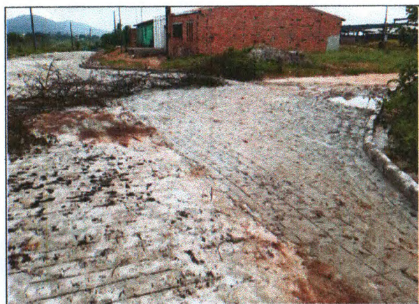
PAVIMENTAÇÃO DO TRECHO 01
