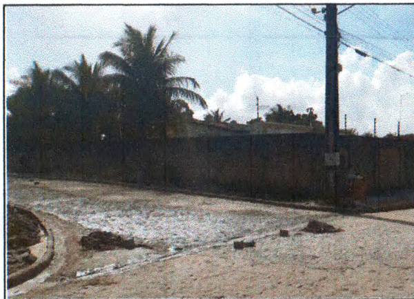
PAVIMENTAÇÃO DA RUA DA PAZ
