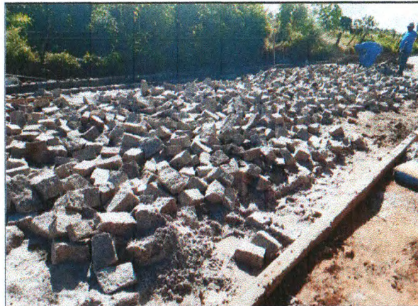
PAVIMENTAÇÃO DO TRECHO 01
