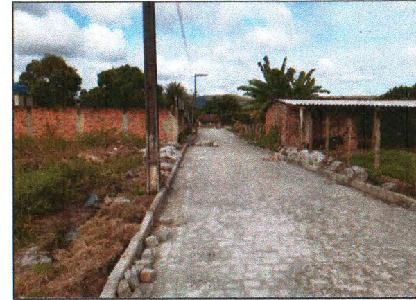
PAVIMENTAÇÃO DA RUA DA PAZ
