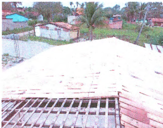
REVISÃO DE COBERTURA EM TELHA CERÂMICA
