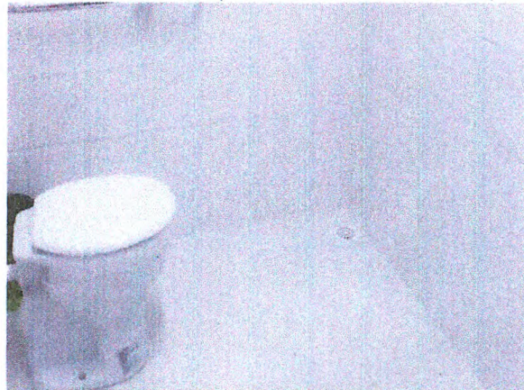
BANHEIRO DEFICIENTE - REVESTIMENTO CERÂMICO; BACIA SANITÁRIA; RALO
