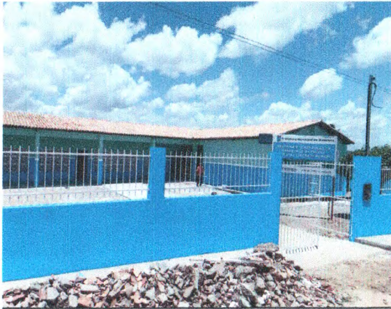
FACHADA DA ESCOLA - PLACA DA OBRA; MURO EM ALVENARIA E GRADIL
