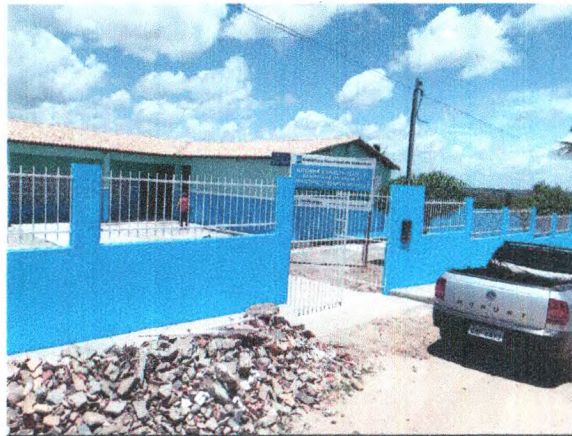
FACHADA DA ESCOLA - MURO EM ALVENARIA; GRADIL E PINTURA
