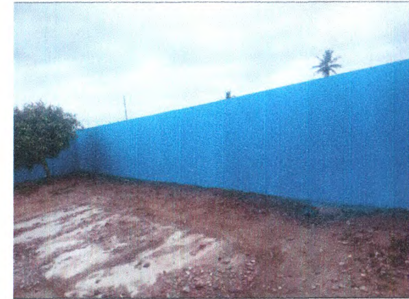
MURO EM ALVENARIA COM PINTURA
