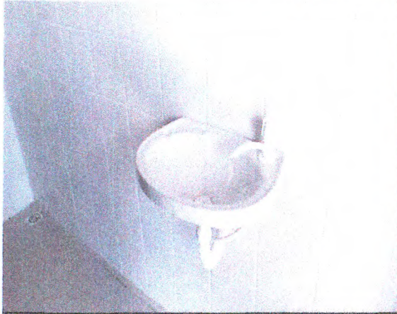
BANHEIRO - REVESTIMENTO CERÂMICO; PONTOS DE ÁGUA E ESGOTO; LAVATÓRIO DE LOUÇA; RALO
