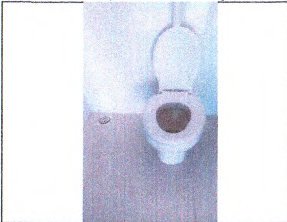
BANHEIRO - REVESTIMENTO CERÂMICO; BACIA SANITÁRIA INFANTIL; RALO
