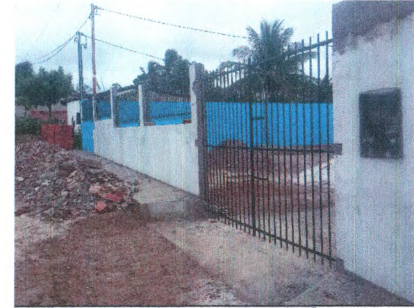
FACHADA DA ESCOLA - CAIXA DE MEDIÇÃO; MURO EM ALVENARIA; PORTÃO DE FERRO; GRADIL E PINTURA
