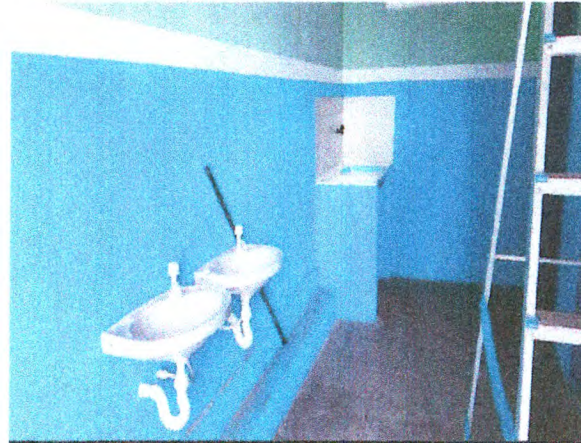
PONTOS DE ÁGUA E ESGOTO; LAVATÓRIO DE LOUÇA; PINTURA INTERNA; PISO DE ALTA RESISTÊNCIA;
