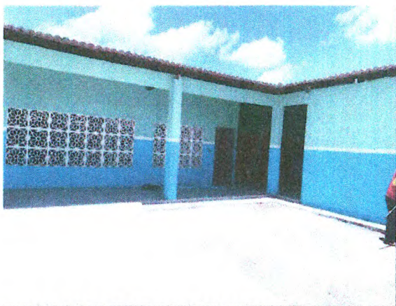
PINTURA DA ESCOLA; EMASSAMENTO DE BEIRAL; POLIMENTO DE PISO ALTA RESISTÊNCIA; PISO CIMENTADO
