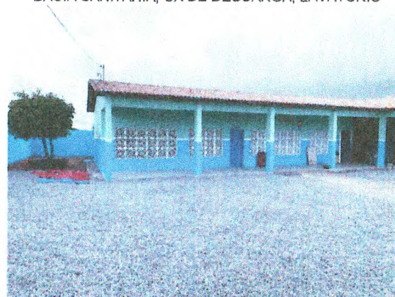
PINTURA DA ESCOLA; EMASSAMENTO DE BEIRAL; PISO CIMENTADO; MURO
