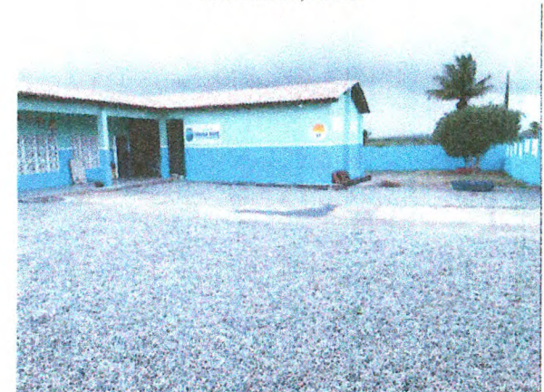
PINTURA DA ESCOLA; EMASSAMENTO DE BEIRAL; PISO CIMENTADO; MURO
