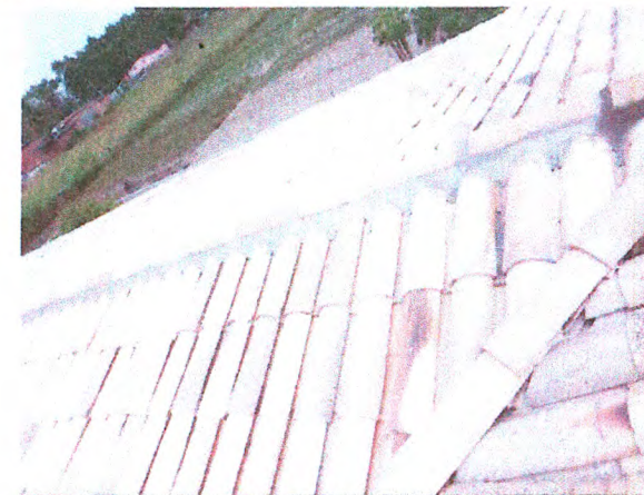
REVISÃO DE COBERTURA EM TELHA CERÂMICA; EMASSAMENTO DE CUMEEIRA
