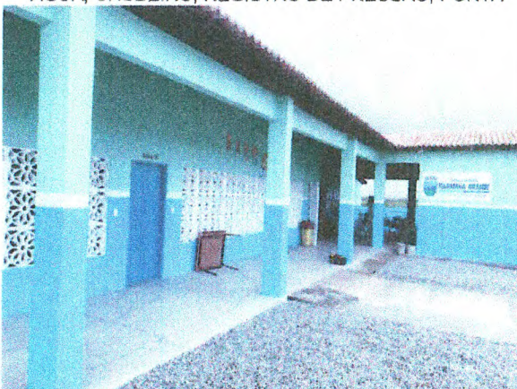
PINTURA DA ESCOLA; EMASSAMENTO DE BEIRAL; PISO CIMENTADO
