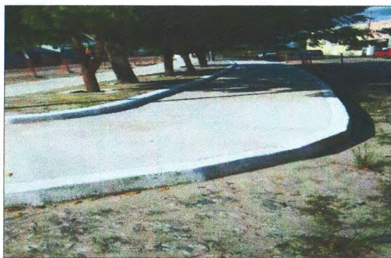
PINTURA DE MEIO FIO
