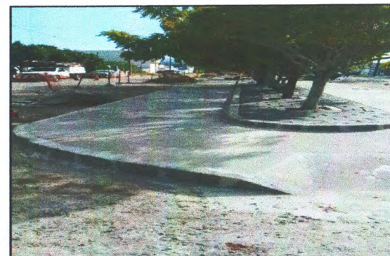
EXECUÇÃO DE PASSEIO
