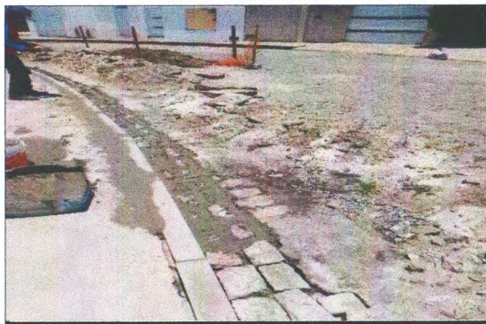
REMOÇÃO E REPOSIÇÃO DE PARAPLEPIEDO
