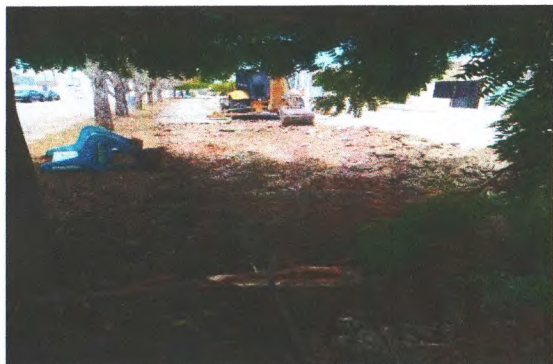
DESTOCAMENTO DE ÁRVORE
