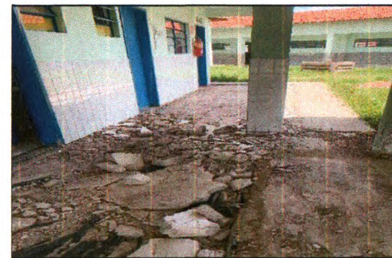
DEMOLIÇÃO DE PISO
