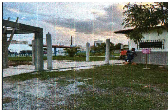
PISO EM CONCRETO (PASSARELA)
