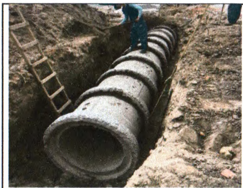
DRENAGEM PROFUNDA - TUBULAÇÃO CENTRAL
