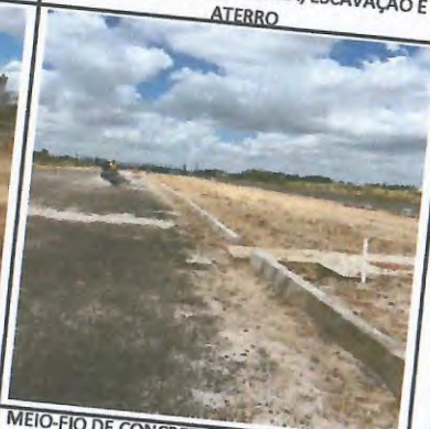
MEIO-FIO DE CONCRETO, LOCAÇÃO DE PRAÇA, MOVIMENTAÇÃO DE TERRA, ESCAVAÇÃO E ATERRO
