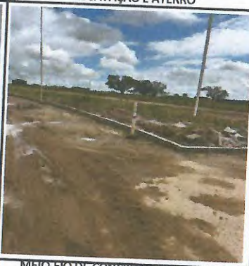
MEIO-FIO DE CONCRETO, LOCAÇÃO DE PRAÇA, MOVIMENTAÇÃO DE TERRA, ESCAVAÇÃO E ATERRO
