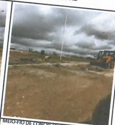
MEIO-FIO DE CONCRETO, LOCAÇÃO DE PRAÇA, MOVIMENTAÇÃO DE TERRA, ESCAVAÇÃO E ATERRO
