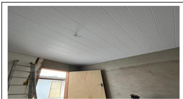
INSTALAÇÃO DE FORRO EM PVC E LUMINÁRIAS EMASSAMENTO
