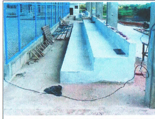
PINTURA DE PAREDE
