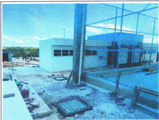
TUBULAÇÃO DE DRENAGEM
