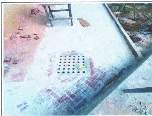
PISO INTERTRAVADO / CAIXA DE DRENAGEM
