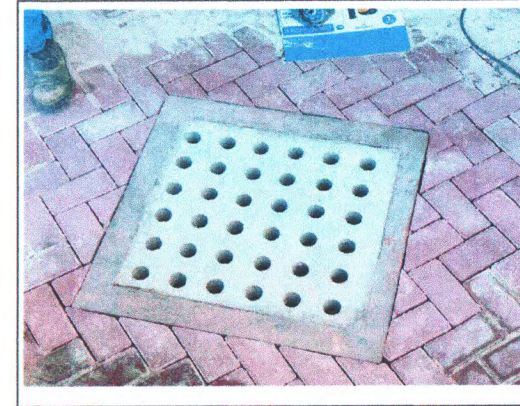
CAIXA DE DRENAGEM
