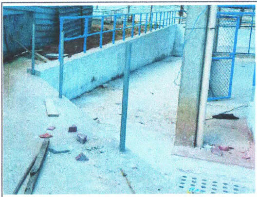
PINTURA DE PAREDE
