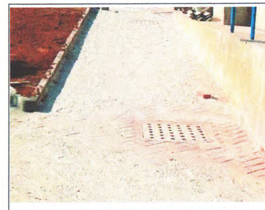
PISO INTERTRAVADO / CAIXA DE DRENAGEM
