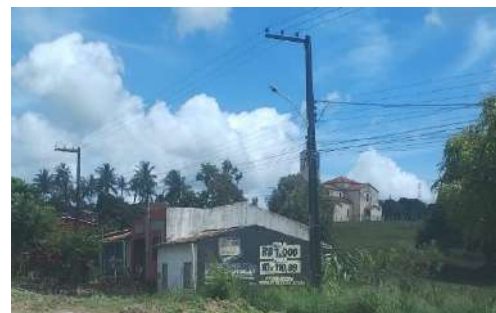
LADO ESQUERDO ATE ACESSO IGREJA – POVOADO RIO DAS PEDRAS
