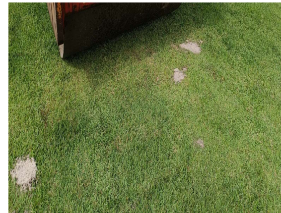
COMPACTAÇÃO DO GRAMADO COM ROLO COMPACTADOR
