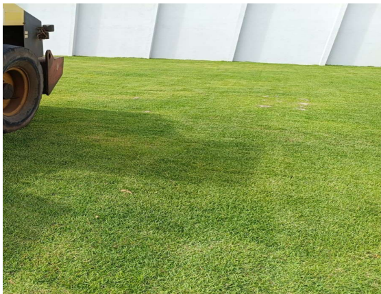
COMPACTAÇÃO DO GRAMADO COM ROLO COMPACTADOR
