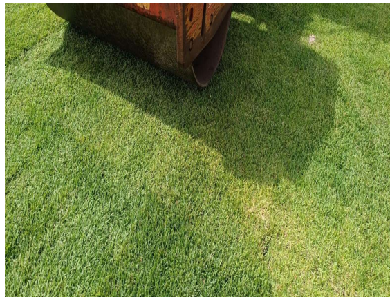
COMPACTAÇÃO DO GRAMADO COM ROLO COMPACTADOR
