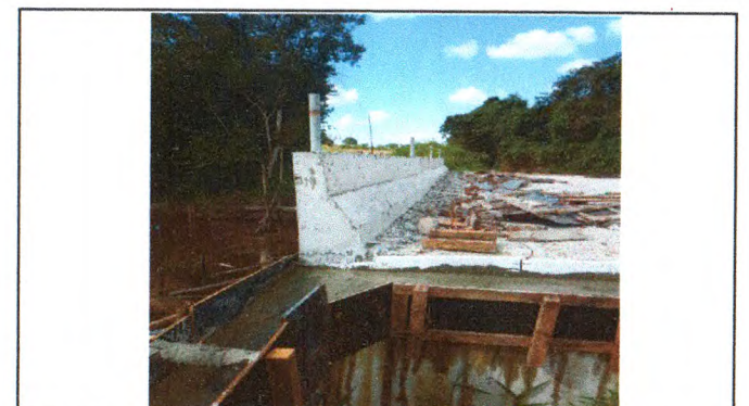
EXECUÇÃO DE BATE-RODAS EM CONCRETO ARMADO
