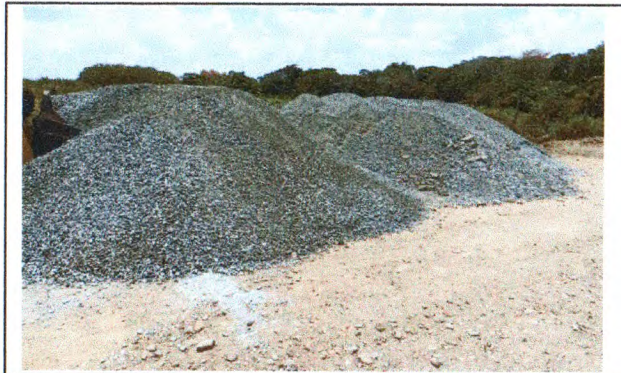
EXECUÇÃO DE TERRAPLANAGEM
