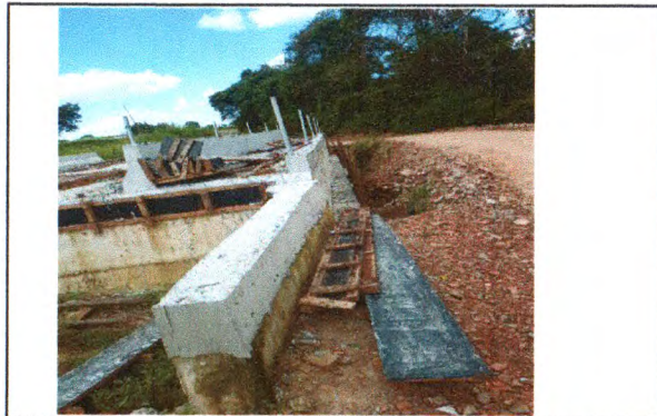
EXECUÇÃO DE BATE-RODAS EM CONCRETO ARMADO
