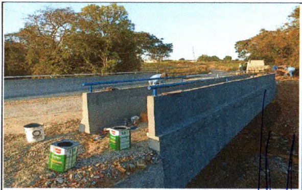
EXECUÇÃO DE ALVENARIAS, REBOCOS E PINTURAS
