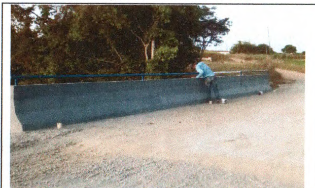
EXECUÇÃO DE ALVENARIAS, REBOCOS E PINTURAS
