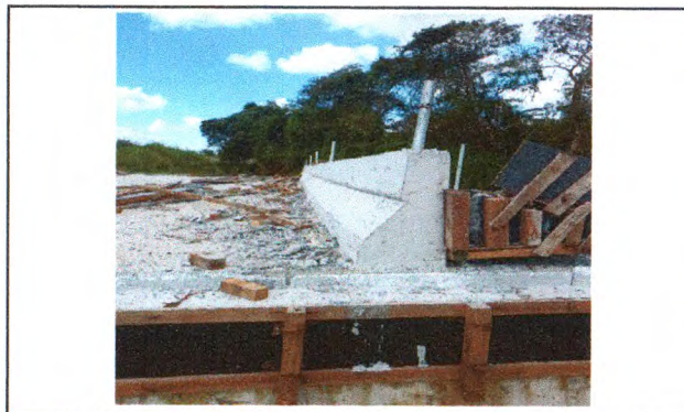
EXECUÇÃO DE BATE-RODAS EM CONCRETO ARMADO
