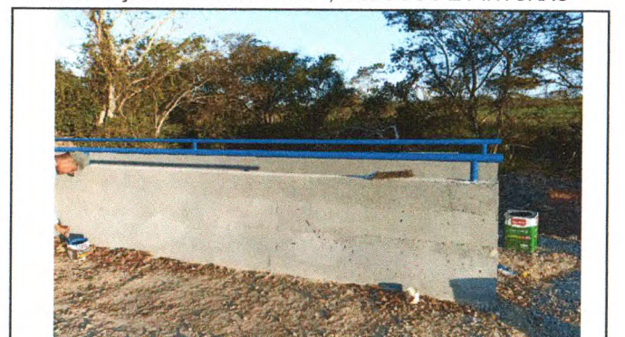
EXECUÇÃO DE ALVENARIAS, REBOCOS E PINTURAS
