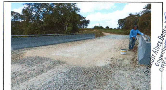
EXECUÇÃO DE ALVENARIAS, REBOCOS E PINTURAS
