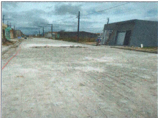
PAVIMENTAÇÃO NA RUA JOSIVAL NUNES DOS SANTOS
