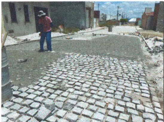
COLCHÃO DE AREIA, MEIO FIO E PARALELEPIPEDO NA RUA RUA JOSÉ ARAÚJO FERREIRA JUNIOR
