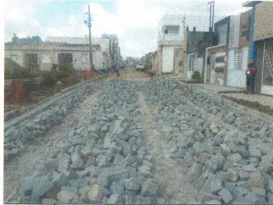
COLCHÃO DE AREIA, MEIO FIO E PARALELEPIPEDO TRECHO DA RUA ERALDO SANTOS
