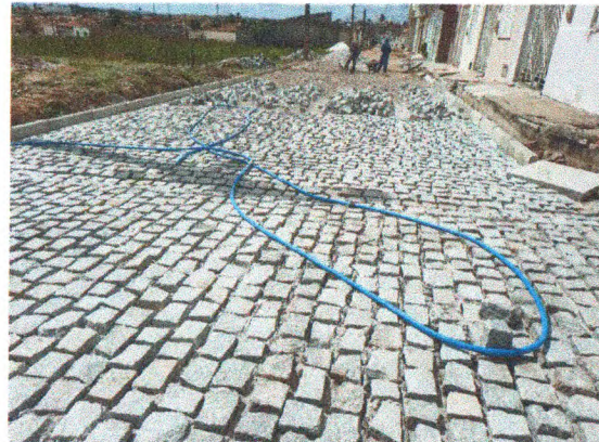
COLCHÃO DE AREIA, MEIO FIO E PARALELEPIPEDO TRECHO DA RUA ERALDO SANTOS
