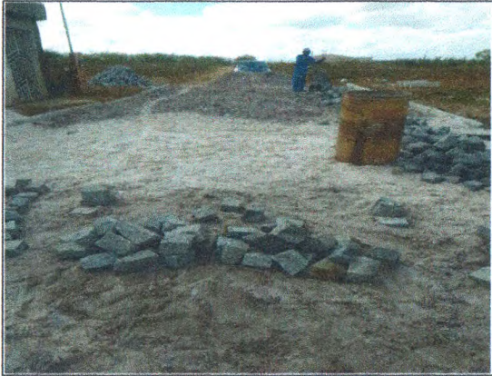
COLCHÃO DE AREIA, MEIO FIO E PARALELEPÍPEDO NA RUA JOÃO CANDIDO DA SILVA
