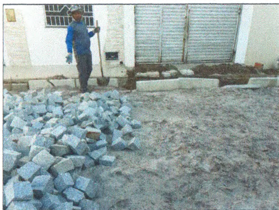
COLCHÃO DE AREIA, MEIO FIO E PARALELEPIPEDO NA RUA MARIA LUIZA MENDONÇA
