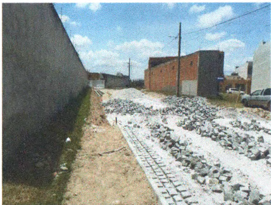
COLCHÃO DE AREIA, MEIO FIO E PARALELEPIPEDO NA RUA JOSÉ ARAÚJO FERREIRA JUNIOR
