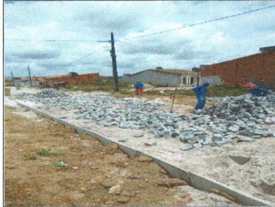
COLCHÃO DE AREIA, MEIO FIO E PARALELEPÍPEDO NA RUA JOÃO CANDIDO DA SILVA
