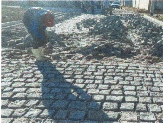
COLCHÃO DE AREIA, MEIO FIO E PARALELEPIPEDO NA RUA TERCILIO PASSOS OLIVEIRA
