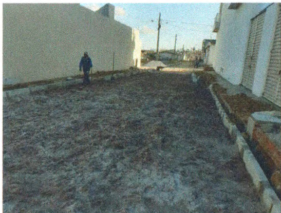
COLCHÃO DE AREIA, MEIO FIO E PARALELEPIPEDO NA RUA MARIA LUIZA MENDONÇA
