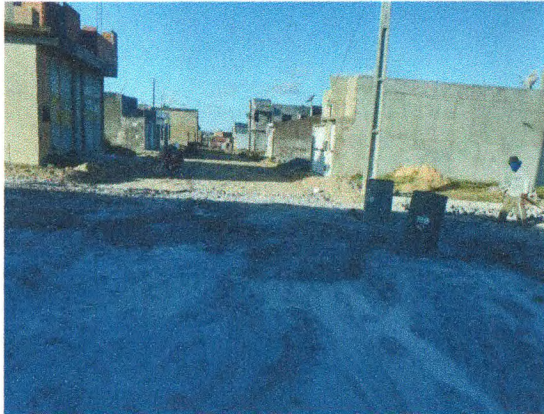
COLCHÃO DE AREIA, MEIO FIO E PARALELEPIPEDO NA RUA TERCILIO PASSOS OLIVEIRA
