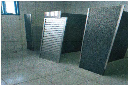
REMOÇÃO DE ESQUADRIAS DE ALUMINIO
