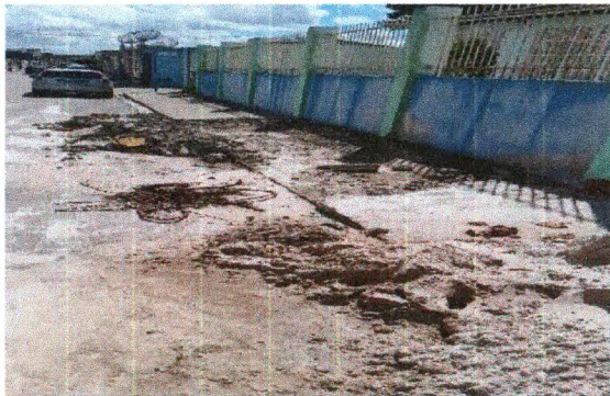
DEMOLIÇÃO MANUAL DE PISO
