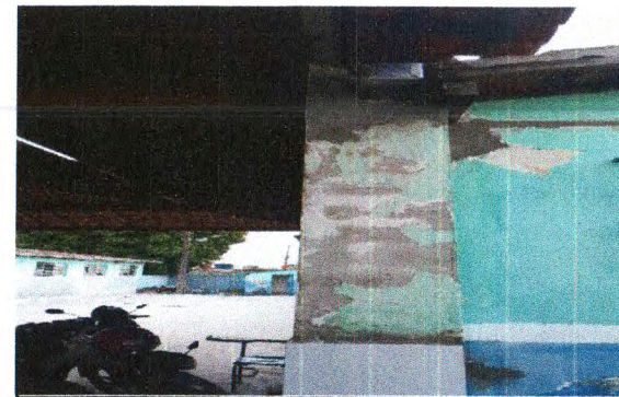
TUBO PVC ( JÁ ESTÁ EMBUTIDO)
