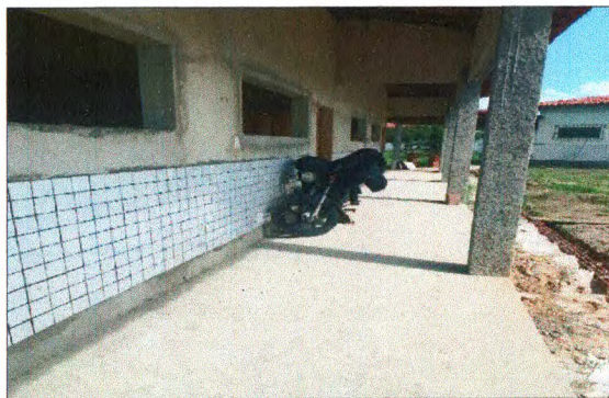
REVESTIMENTO PAREDE SALAS
