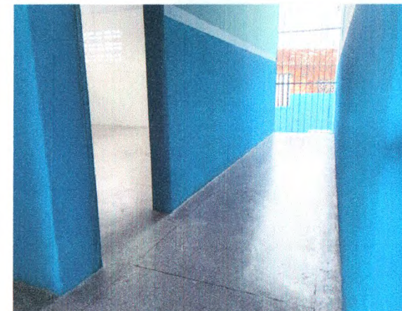
POLIMENTO E ENCERAMENTO DO PISO EM ALTA RESISTÊNCIA; PINTURA INTERNA
