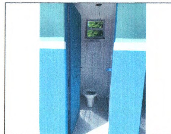
WC - REVESTIMENTO CERÂMICO; PORTA DE MADEIRA; REVISÃO DE PONTOS ÁGUA E ESGOTO
