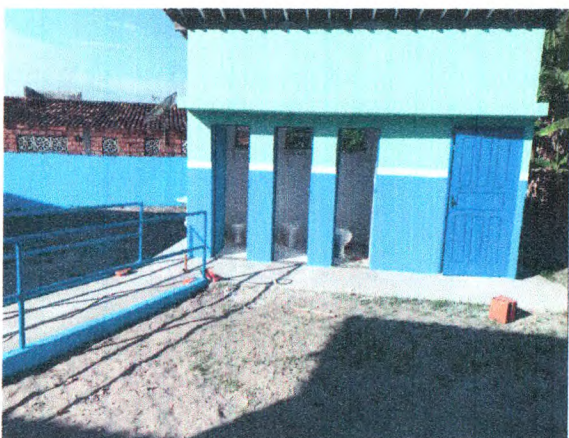
BANHEIROS -PINTURA EXTERNA; REVESTIMENTO CERÂMICO PAREDE; PORTAS DE MADEIRA; PISO EM CONCRETO DESEMPOLADO
