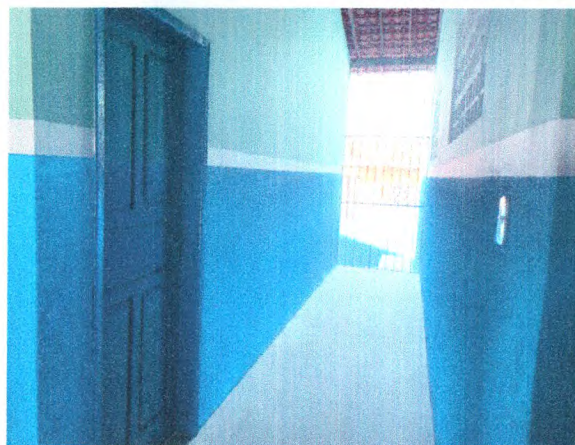
AMPLIAÇÃO - PORTA DE MADEIRA; PISO DE ALTA RESISTÊNCIA; PINTURA INTERNA
