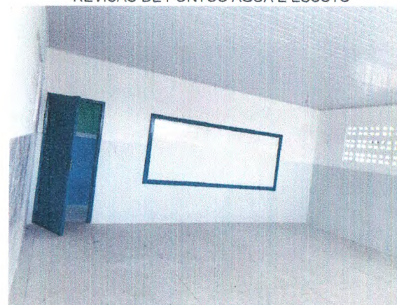
SALA DE AULA - PORTA EM MADEIRA; QUADRO EM FÓRMICA; PINTURA INTERNA DE PAREDES; FORRO DE PVC; PISO EM ALTA RESISTÊNCIA
