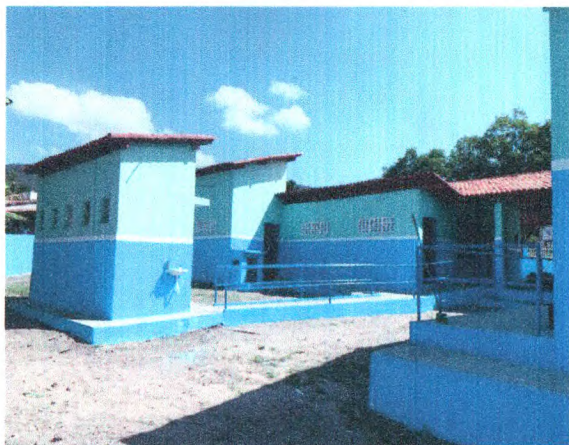
PINTURA EXTERNA; LIMPEZA DO TERRENO
