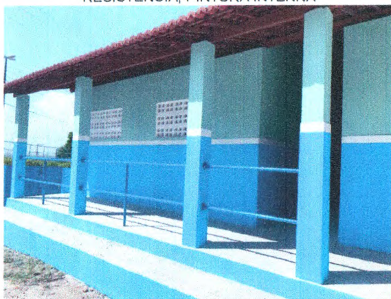
TELHAMENTO CERÂMICO; MADEIRAMENTO EM MASSARANDUBA; EMASSAMENTO DE BEIRAL; COMBOGÔ; GUARDA CORPO METÁLICO; PINTURA EXTERNA
