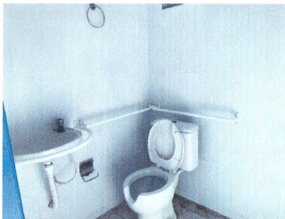
WC PCD - REVESTIMENTO CERÂMICO; LOUÇAS E METÁIS; REVISÃO DE PONTOS ÁGUA E ESGOTO
