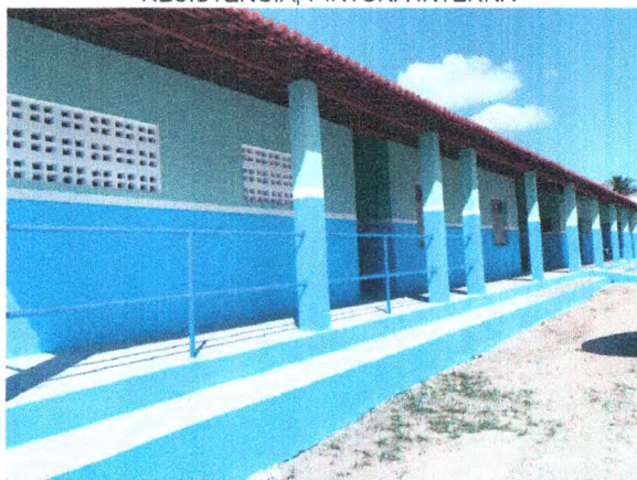
TELHAMENTO CERÂMICO; MADEIRAMENTO EM MASSARANDUBA; EMASSAMENTO DE BEIRAL; COMBOGÔ; GUARDA CORPO METÁLICO; PINTURA EXTERNA
