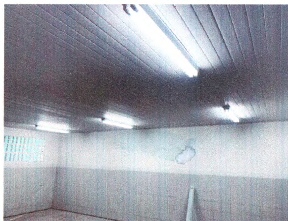
SALA DE AULA - FORRO DE PVC; LUMINÁRIAS; PINTURA INTERNA
