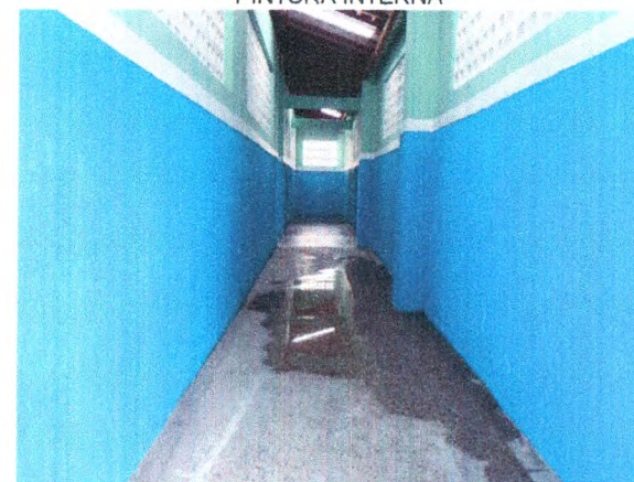
PINTURA INTERNA PAREDES E COMBOGÓS; PISO EM ALTA RESISTÊNCIA
