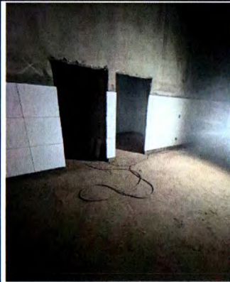
REVESTIMENTO CERÂMICO
