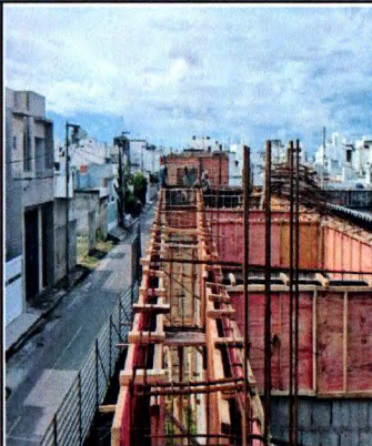
CORTE E DOBRA DE AÇO DA LAJE NÍVEL 615
