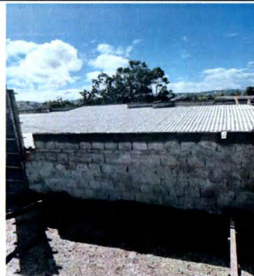
ALVENARIA DE VEDAÇÃO DA MARQUISE
