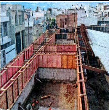
CORTE E DOBRA DE AÇO DA LAJE NÍVEL 615
