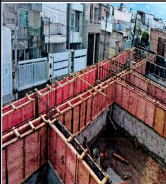
CORTE E DOBRA DE AÇO DA LAJE NÍVEL 615
