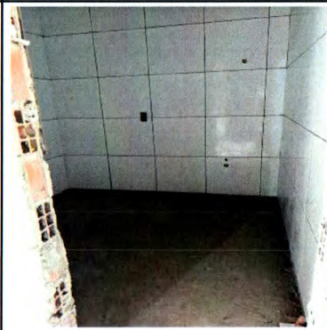
REVESTIMENTO CERÂMICO
