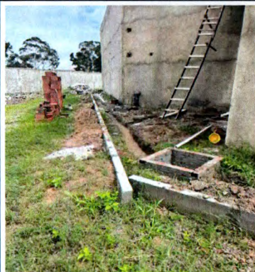
MEIO FIO E INSTALAÇÕES SANITÁRIA
