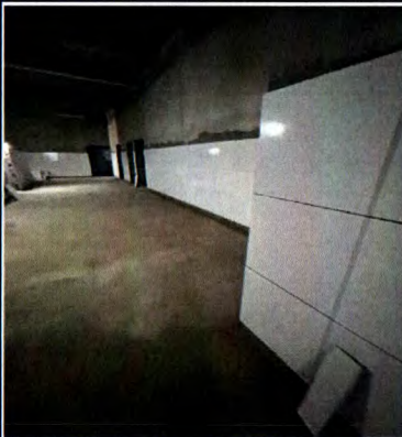
REVESTIMENTO CERÂMICO
