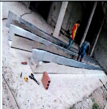
RUFO, CALHA, CUMEEIRA E INSTALAÇÕES DE DRENAGEM
