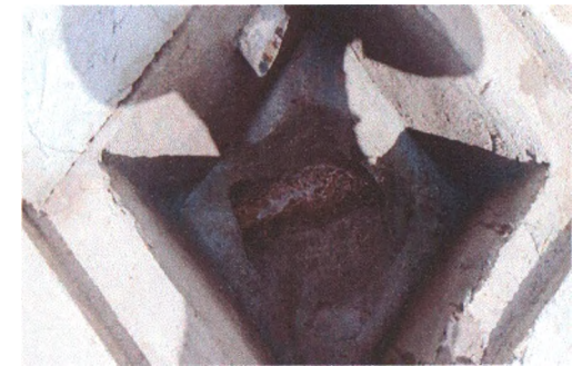
Execução de Caixa de Gordura
