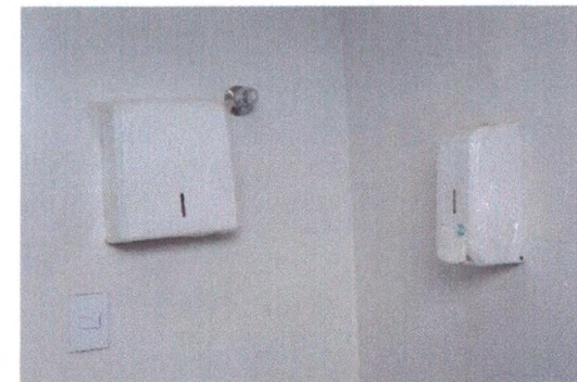
Execução de Porta Papel Toalha e Saboneteira
