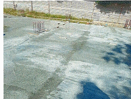
CONCRETO DA LAJE; ARRANQUES DOS PILARES
