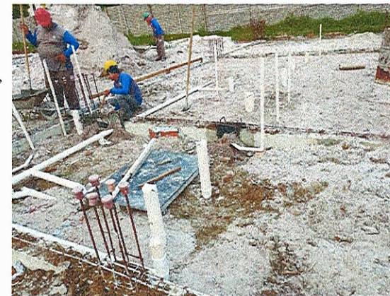
INSTALAÇÕES SANITÁRIAS; ATERRO COMPACTADO
