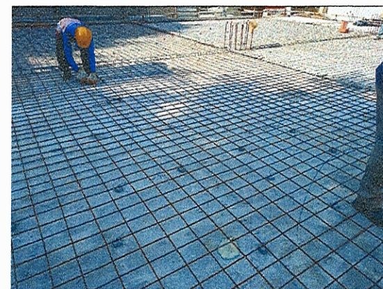
CAMADA IMPERMEABILIZADORA; MONTAGEM DA FERRAGEM DA LAJE
