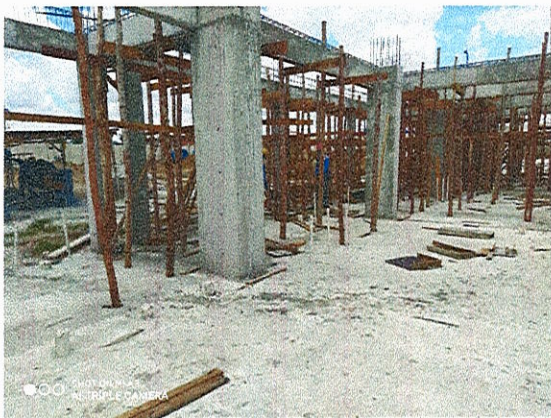
PILARES E VIGAS EM CONCRETO ARMADO
