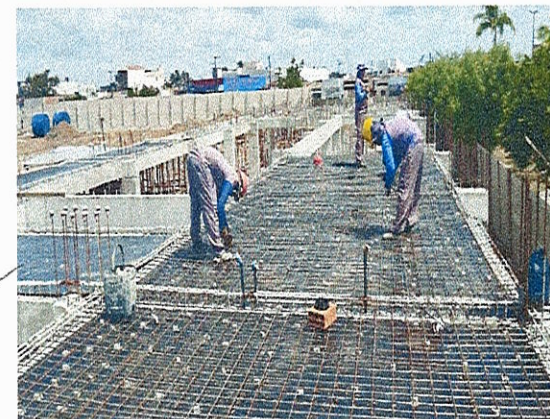
FORMA E ARMAÇÃO DAS LAJES
