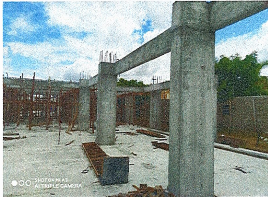
PILARES E VIGAS EM CONCRETO ARMADO
