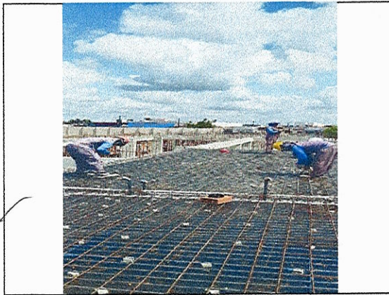
FORMA E ARMAÇÃO DAS LAJES
