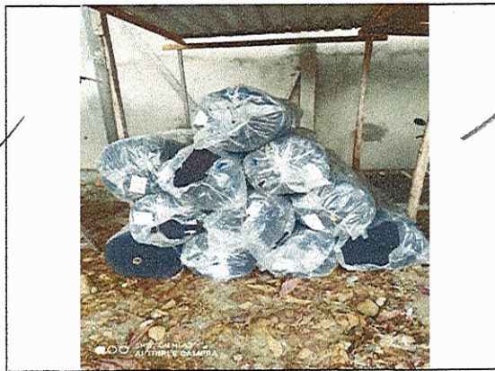
DRENAGEM - MANTA GEOTEXTIL (BIDIM)
