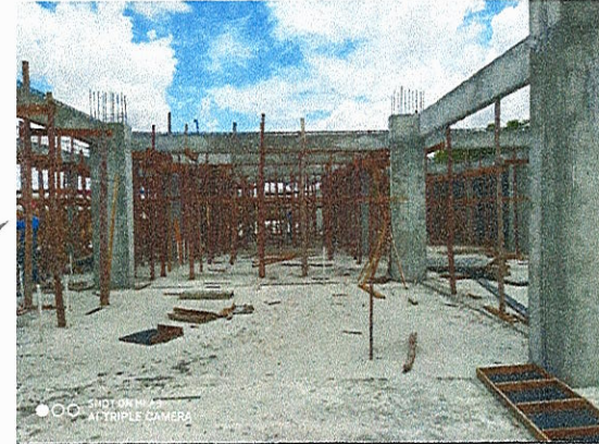
PILARES E VIGAS EM CONCRETO ARMADO
