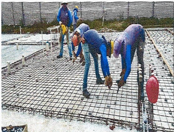
INSTALAÇÃO SANITÁRIA; CAMADA IMPERMEABILIZADORA; ARMAÇÃO E CONCRETO LAJE
