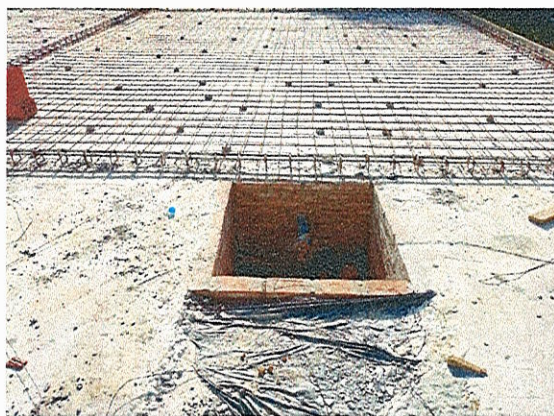
ATERRO COMPACTADO; CAMADA IMPERMEABILIZADORA; MONTAGEM DA FERRAGEM DA LAJE; CAIXA DE PASSAGEM
