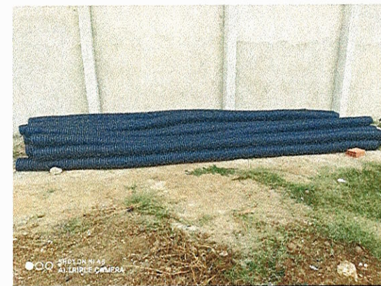
DRENAGEM - TUBULAÇÃO PEAD FLEXÍVEL CORRUGADO PERFURADO
