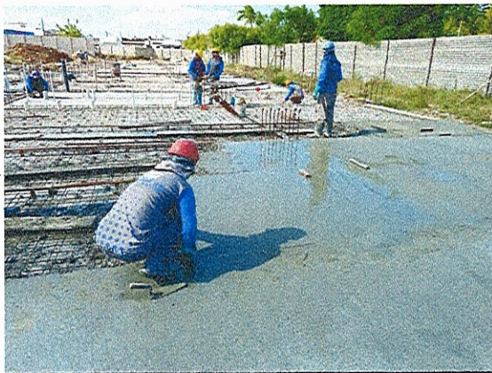
INSTALAÇÃO SANITÁRIA; ARMAÇÃO E CONCRETAGEM DA LAJE
