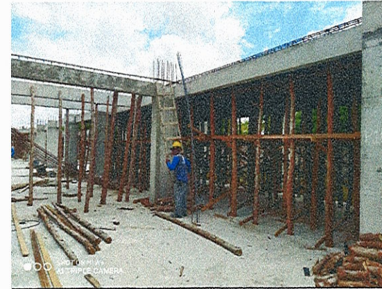
PILARES E VIGAS EM CONCRETO ARMADO; FORMA E ESCORAMENTO DAS LAJES
