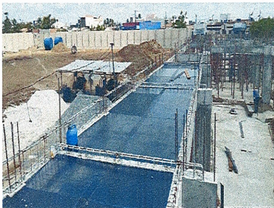
PILARES E VIGAS EM CONCRETO ARMADO; FORMA DAS LAJES
