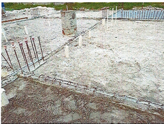
INSTALAÇÕES SANITÁRIAS; ATERRO COMPACTADO
