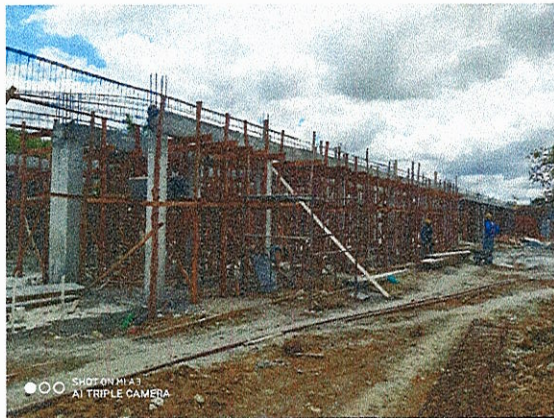
PILARES E VIGAS EM CONCRETO ARMADO
