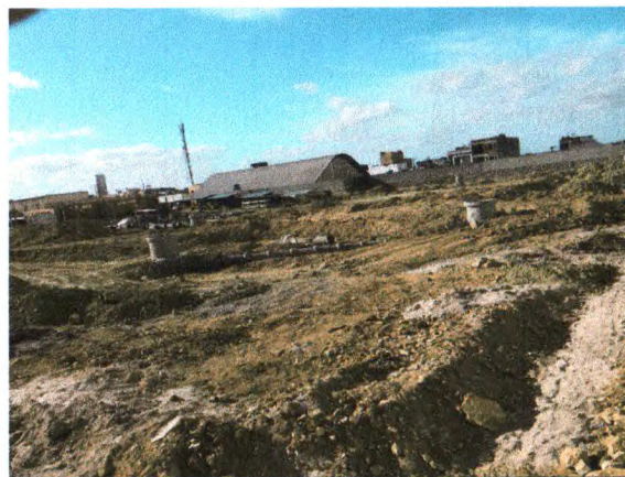
TERRAPLANAGEM E EXECUÇÃO DE SUB-BASE;
