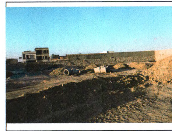
TERRAPLANAGEM E EXECUÇÃO DE SUB-BASE; CHAPISCO E REBOCO NO MURO;
