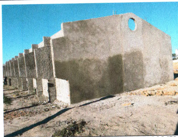
EXECUÇÃO DO CHAPISCO E REBOCO NO BLOCO "B";
