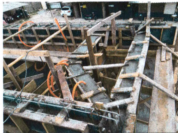
EXECUÇÃO DAS VIGAS DO BLOCO C - ESCORAMENTO, FORMA, FERRAGEM E CONCRETO;
