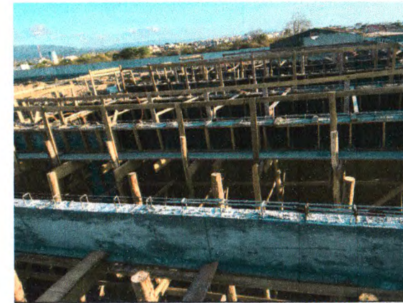
EXECUÇÃO DAS VIGAS DO BLOCO C - ESCORAMENTO, DESFORMA, FERRAGEM E CONCRETO;
