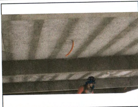
PONTO ELÉTRICO DE ILUMINAÇÃO; CHAPISCO DE TETO
