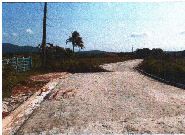
PAVIMENTAÇÃO DO TRECHO 04
