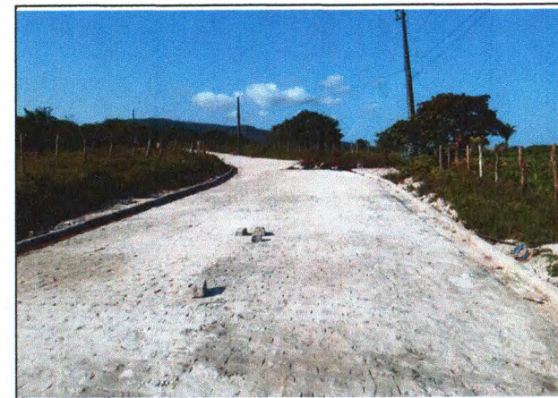
PAVIMENTAÇÃO DO TRECHO 04
