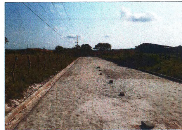
PAVIMENTAÇÃO DO TRECHO 04
