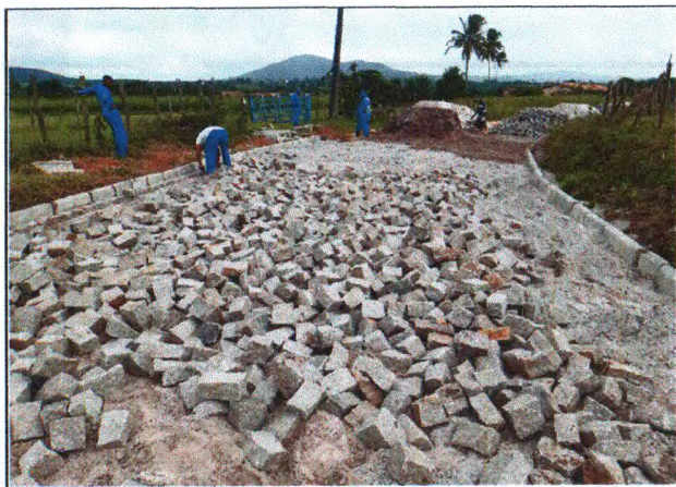
PAVIMENTAÇÃO DO TRECHO 04
