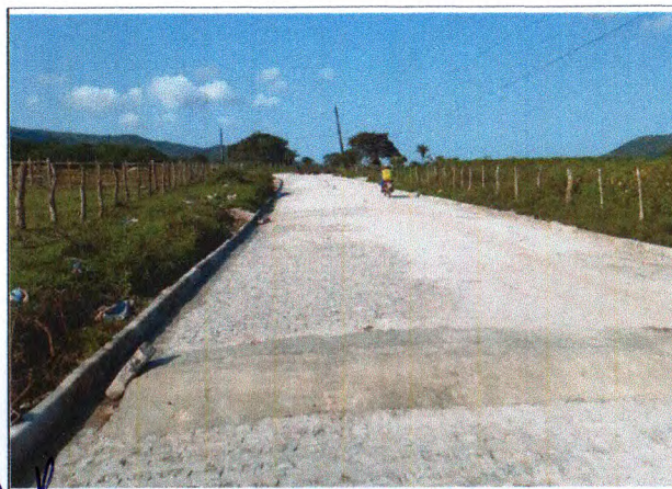
PAVIMENTAÇÃO DO TRECHO 04
