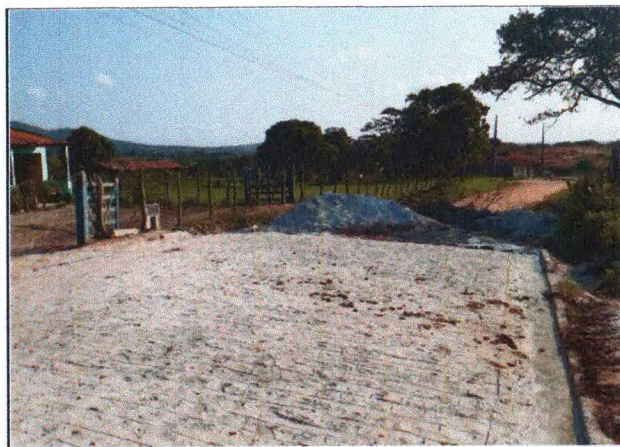
PAVIMENTAÇÃO DO TRECHO 04
