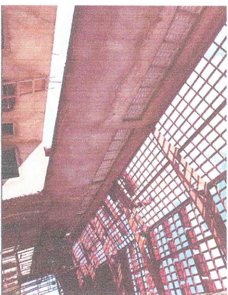
BAIAS COBERTAS - TESOURAS, PEÇAS, RIPÕES E RIPAS EM MADEIRA; TELHAMENTO CERÂMICO
