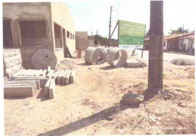
MEIO FIO, ATERRO E REGULARIZAÇÃO
