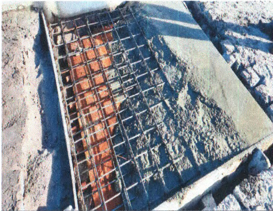
RUA ESPERIDIÃO NORONHA - DRENAGEM
