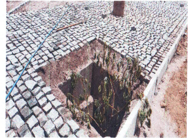
RUA ESPERIDIÃO NORONHA - DRENAGEM
