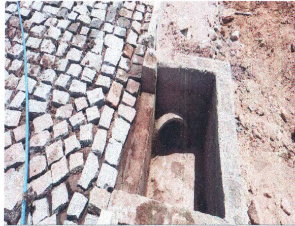
RUA ESPERIDIÃO NORONHA - DRENAGEM
