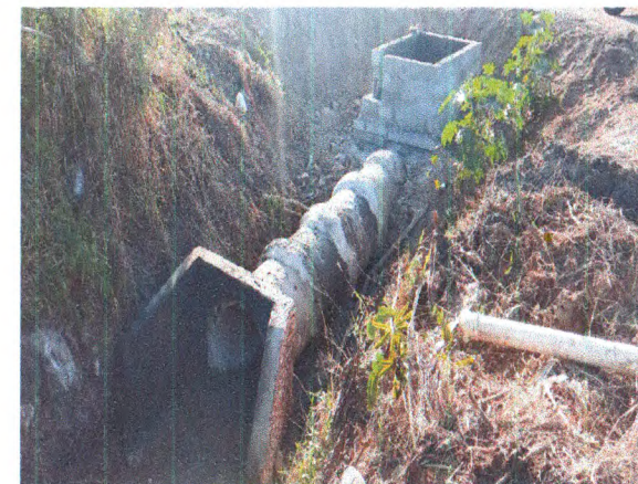
RUA ESPERIDIÃO NORONHA - DRENAGEM
