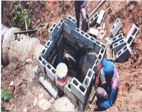
RUA ESPERIDIÃO NORONHA - DRENAGEM
