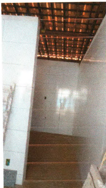
Fotos 06. Execução de revestimento em espaço no vestiário
