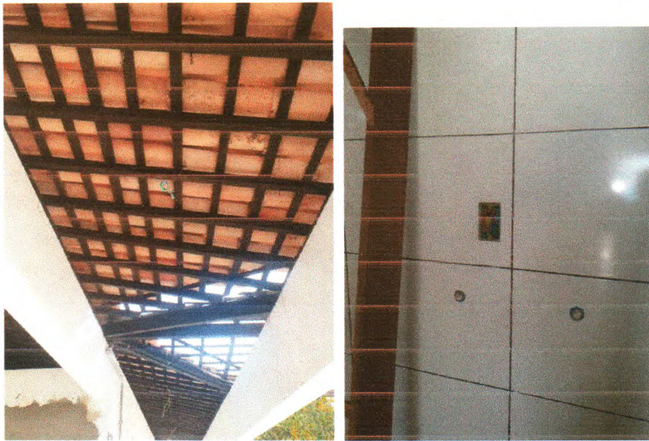
Fotos 08. Substituição de eletrodutos e instalação de cabeamento para pontos de luz e tomadas
