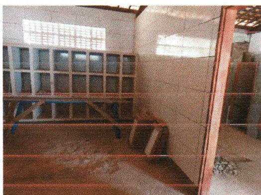
Fotos 01. Instalação de caixões de portas, batentes e revestimentos
