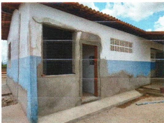
Fotos 01. Instalação de caixões de portas, batentes e revestimentos
