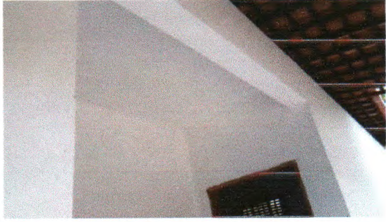
Fotos 10. Instalação de forro de gesso
