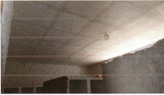
Fotos 10. Instalação de forro de gesso
