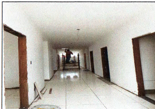
Execução do revestimento, soleiras e pintura 01
