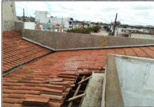
Execução dos rufos 01
