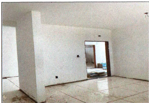
Execução do revestimento, soleiras e pintura 03
