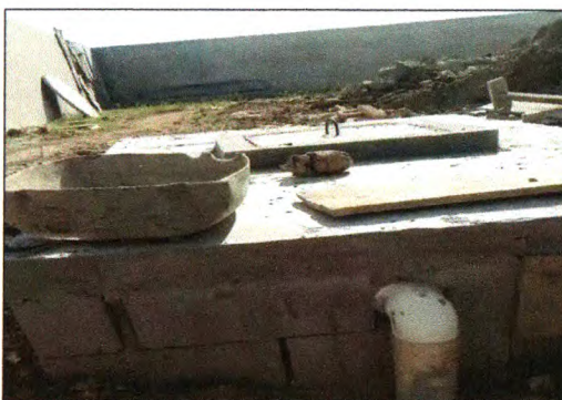
Execução da fossa e filtro 01
