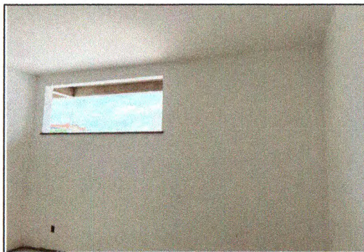
Execução de pintura e peitoril
