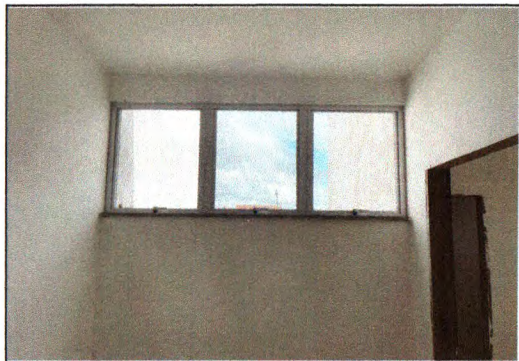
Execução das janelas de alumínio 03
