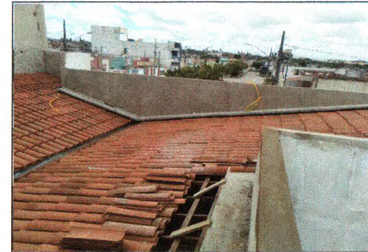
Execução dos rufos 03
