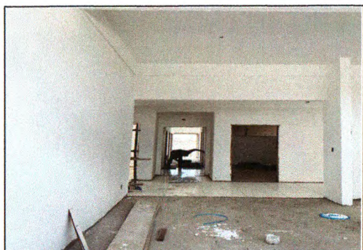
Execução do revestimento, soleiras e pintura 06
