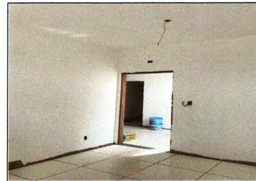
Execução do revestimento, soleiras e pintura 05
