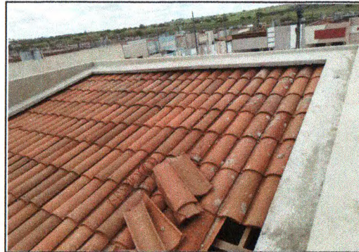
Execução dos rufos 02
