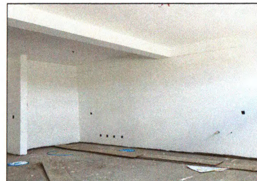
Execução de pintura 02
