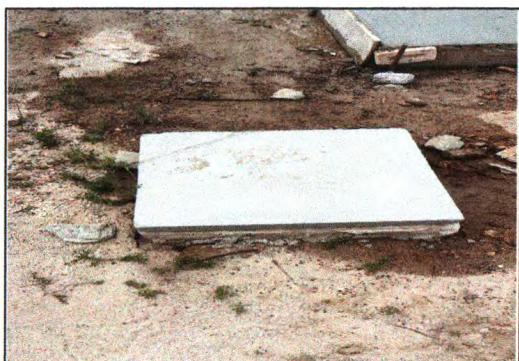
Execução das caixas de passagens
