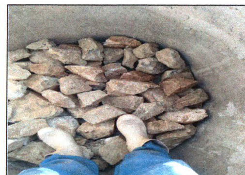
Execução da fossa e filtro 02
