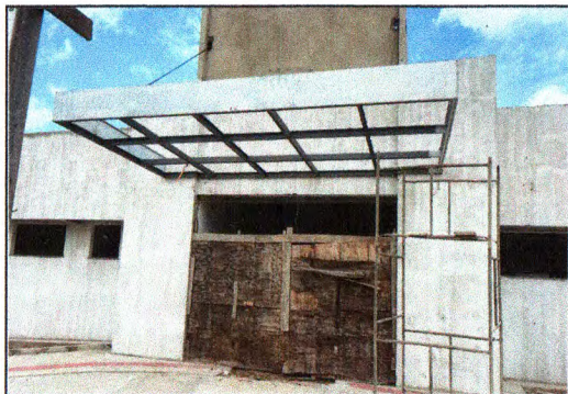
Execução da cobertura metálica
