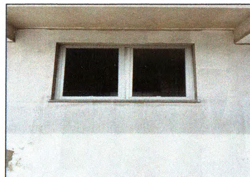
Execução das janelas de alumínio 02
