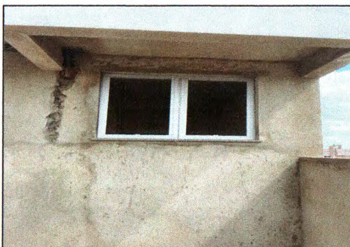
Execução das janelas de alumínio 01
