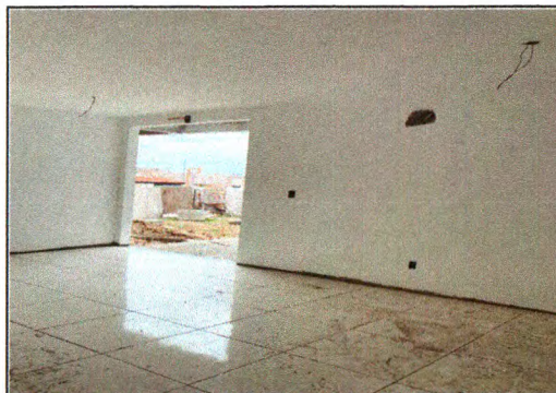
Execução do revestimento, soleiras e pintura 04
