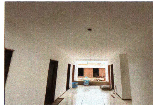
Execução do revestimento, soleiras e pintura 02
