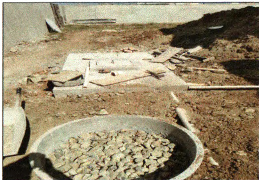
Execução da fossa e filtro 03
