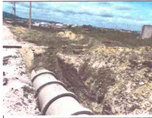
DRENAGEM PROFUNDA - TUBULAÇÃO CENTRAL E ATERRO COM AREIA
