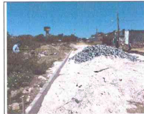
COLCHÃO DE AREIA E ASSENTAMENTO DE MEIO-FIO - RUA PEDRO BARBOSA DE JESUS
