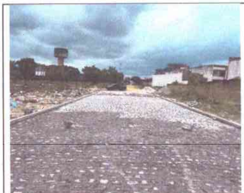
PAVIMENTAÇÃO E DRENAGEM SUPERFICIAL - RUA PEDRO BARBOSA DE JESUS
