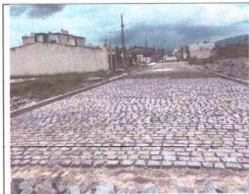
PAVIMENTAÇÃO, DRENAGEM SUPERFICIAL E ASSENTAMENTO DE MEIO-FIO - RUA PEDRO BARBOSA DE JESUS
