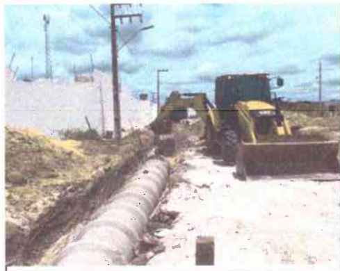
DRENAGEM PROFUNDA - ESCAVAÇÃO E ASSENTAMENTO DE TUBULAÇÃO
