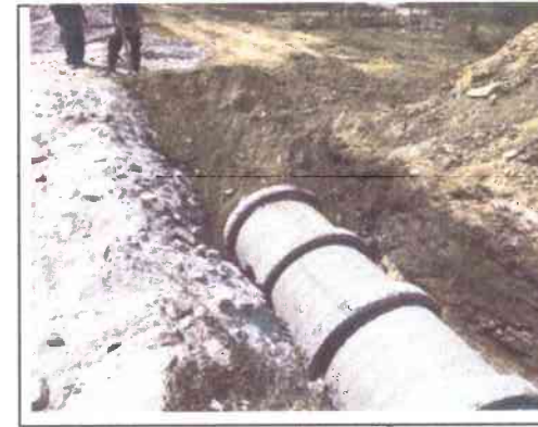
DRENAGEM PROFUNDA - TUBULAÇÃO CENTRAL E ATERRO COM AREIA
