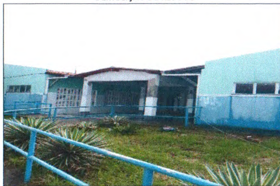
EMASSAMENTO DE BEIRAL SALA DO FUNDO
