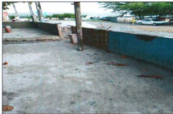
DEMOLIÇÃO DE REBOCO
