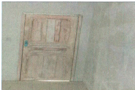
REVISÃO ESQUADRIA DE MADEIRA
