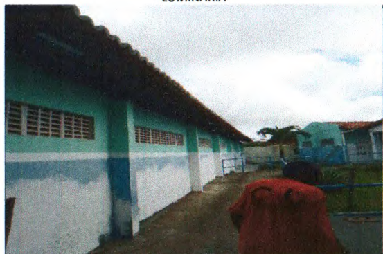
EMASSAMENTO DE BEIRAL
