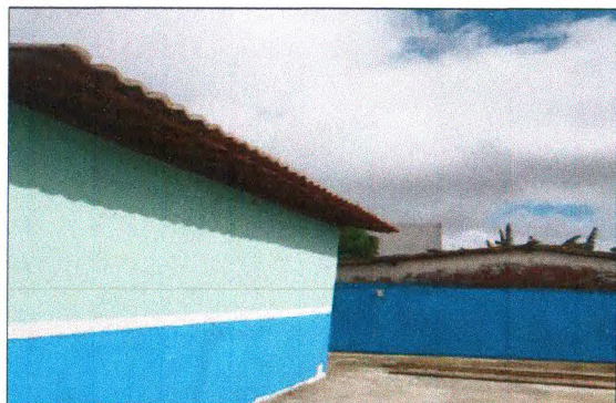
EMASSAMENTO DE BEIRAL
