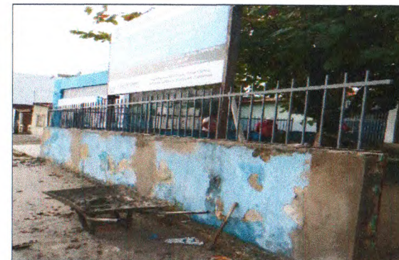
DEMOLIÇÃO DE PISO
