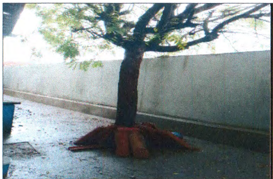
REBOCO DE MURO
