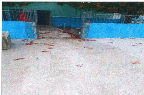
PISO EM CONCRETO
