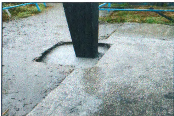
CONCRETO SALA DO FUNDO
