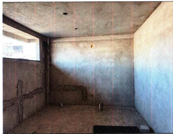
REBOCO INTERNO E REGISTRO
