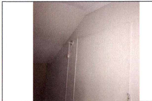
EMASSAMENTO E PINTURA EM PAREDE
