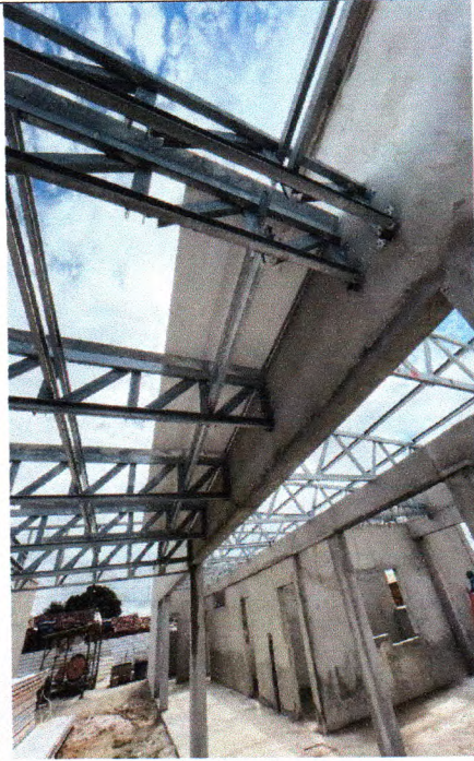
Figura 17: Telhamento com telha em aço galvanizado, dupla trapezoidal, na etapa B
