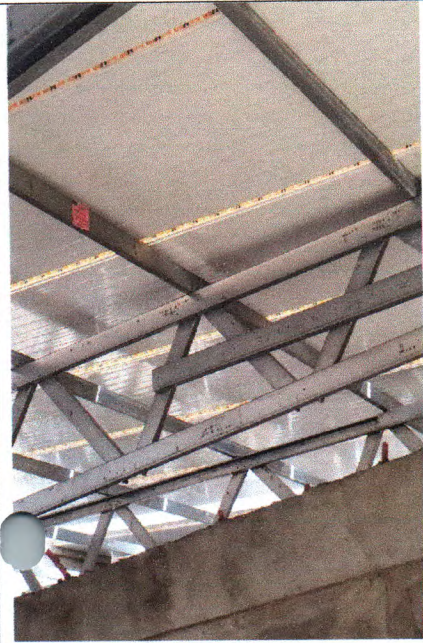
Figura 19: Telhamento com telha em aço galvalume, dupla trapezoidal, na etapa B
