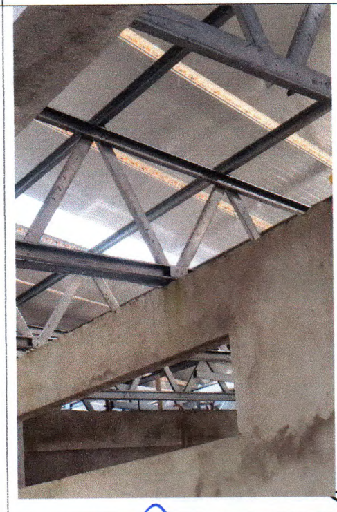
Figura 18: Telhamento com telha em aço galvanizado nas etapas A e C
