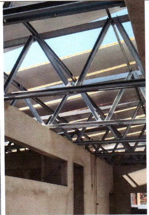
Figura 18: Telhamento com telha em aço galvanizado nas etapas A e C
