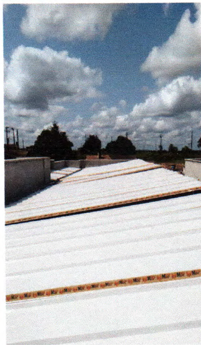
Figura 17: Telhamento com telha em aço galvanizado, dupla trapezoidal, na etapa B
