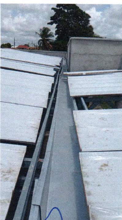
Figura 12: Calha em chapa de aço galvanizado número 24, desenvolvimento de 80 cm, incluso transporte vertical.
