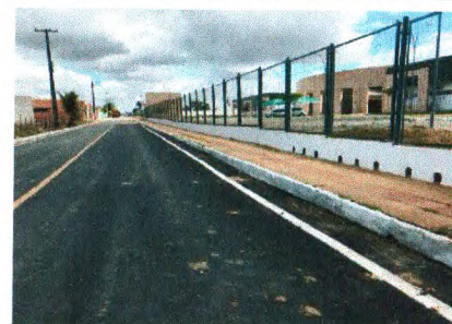
MEIO-FIO - AV. PADRE AIRTON GONÇALVES
