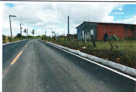
MEIO-FIO - AV. PADRE AIRTON GONÇALVES
