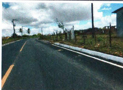
MEIO-FIO - AV. PADRE AIRTON GONÇALVES
