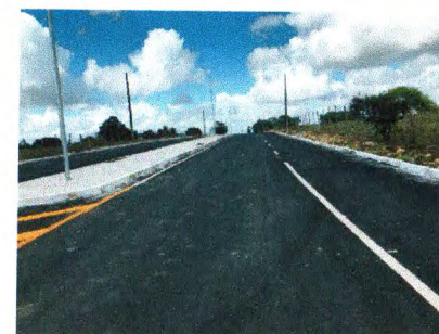
MEIO-FIO - AV. IRMÃ MARIA AUXILIADORA
