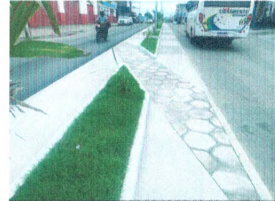
PISO HEXAGONAL; PINTURA DE MEIO-FIO E PISO EM CONCRETO DESEMPOLADO; GRAMA E PLANTAS
