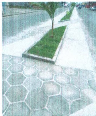
PISO DE BLOCO HEXAGONAL EM CONCRETO; MEIO-FIO E PISO EM CONCRETO DESEMPOLADO; GRAMA E
