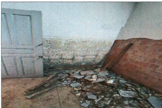
DEMOLIÇÃO DE PISO CERÂMICO
