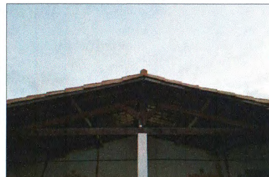
EMASSAMENTO DE BEIRAL
