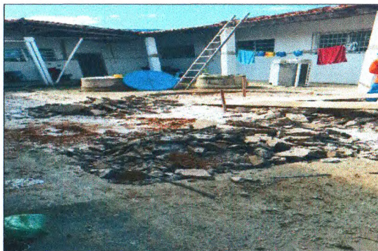
DEMOLIÇÃO MANUAL DE PISO
