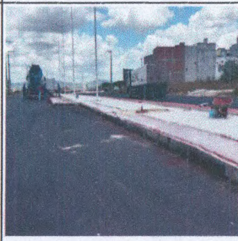
CICLOVIA: PAVIMENTAÇÃO EM CONCRETO COLORIDO USINADO
