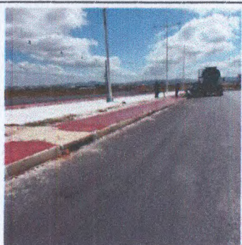
CICLOVIA: PAVIMENTAÇÃO EM CONCRETO COLORIDO USINADO
