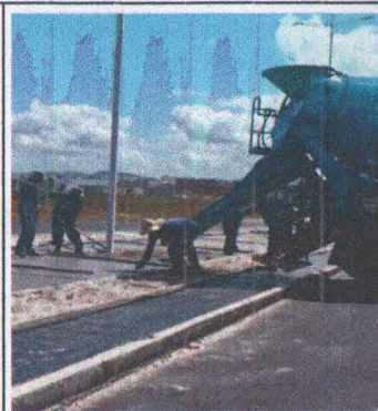
PISO EM CONCRETO COM LONA
