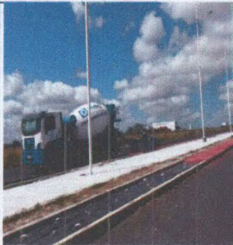
CICLOVIA: PAVIMENTAÇÃO EM CONCRETO COLORIDO USINADO
