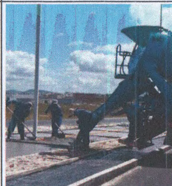
PISO EM CONCRETO COM LONA
