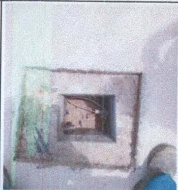
CABO PP DE ALIMENTAÇÃO DOS POSTES DE ILUMINAÇÃO PÚBLICA
