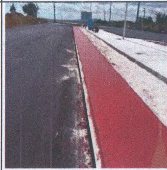
CICLOVIA: PAVIMENTAÇÃO EM CONCRETO COLORIDO USINADO
