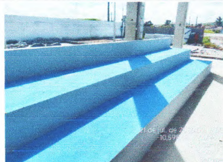
PINTURA DA ARQUIBANCADA
