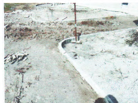
ASSENTAMENTO DE MEIO-FIO
