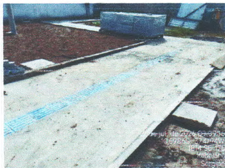
EXECUÇÃO DE PISO EM CONCRETO
