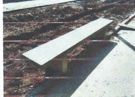
BANCO DE CONCRETO
