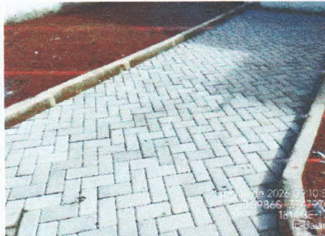
EXECUÇÃO DE PISO INTERTRAVADO
