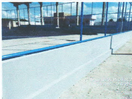
PINTURA DAS MURETAS
