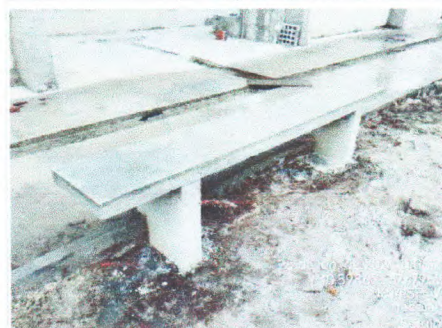
BANCO DE CONCRETO
