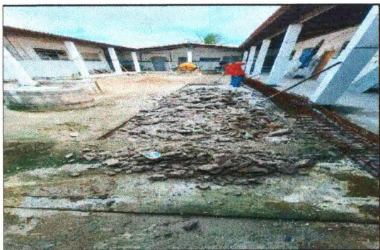
DEMOLIÇÃO MANUAL DE PISO
