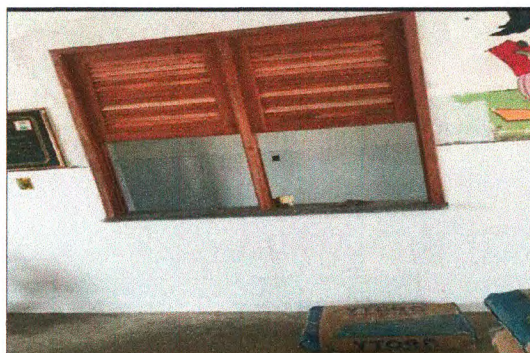
JANELA EM MADEIRA
