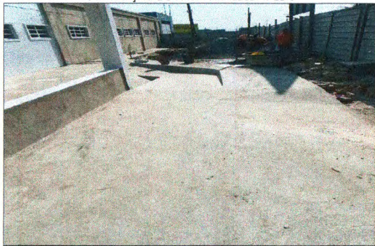
PISO EM CONCRETO
