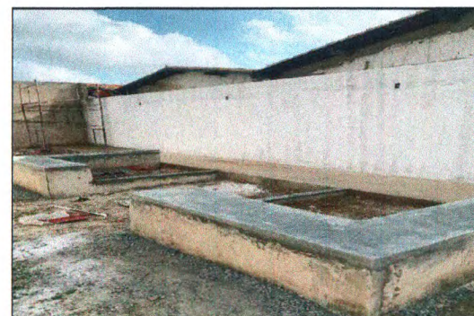
BANCO EM CONCRETO
