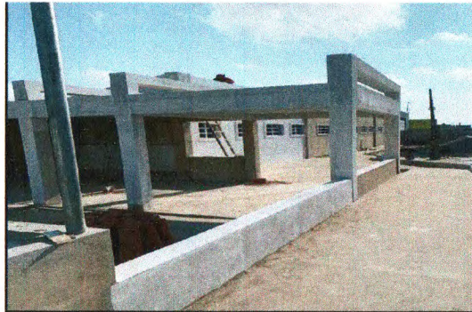
ALVENARIA DE BLOCO
