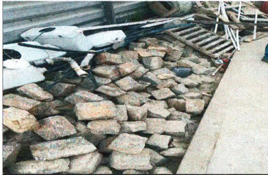
DEMOLIÇÃO DE PAV. PARALELEPIPEDO
