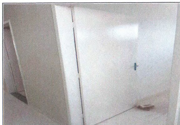
Porta de madeira de 0,80m - 03
