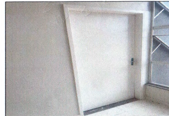
Porta de madeira de 0,80m - 01
