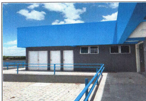
Esquadria de alumínio e pintura externa
