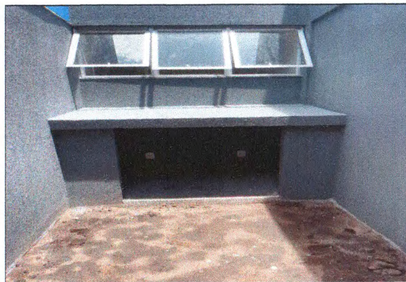
Laje, impermeabilização e pintura externa 02
