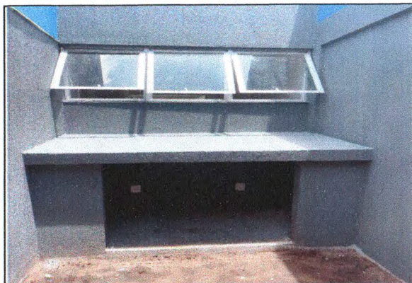
Laje, impermeabilização e pintura externa 01
