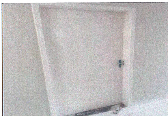
Porta de madeira de 0,80m - 02
