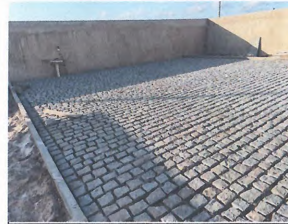
PAVIMENTAÇÃO EM PARALELEPÍPEDO
