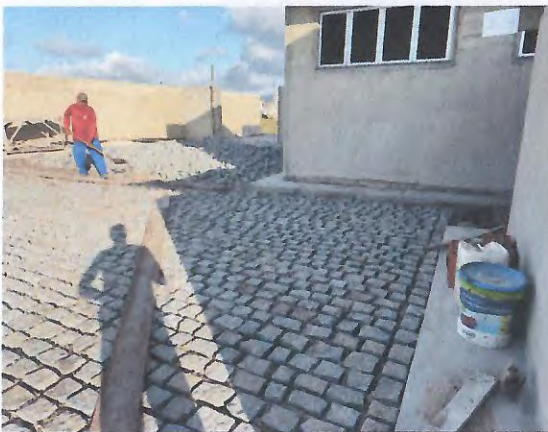
PAVIMENTAÇÃO EM PARALELEPÍPEDO
