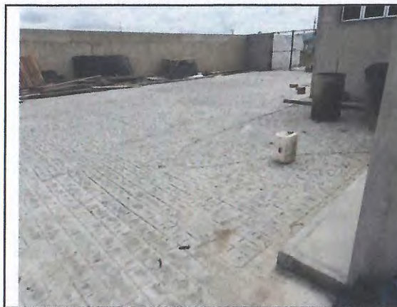
PAVIMENTAÇÃO EM PARALELEPÍPEDO E PORTÃO DE FERRO
