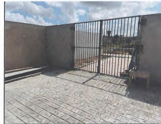
PAVIMENTAÇÃO EM PARALELEPÍPEDO E PORTÃO DE FERRO
