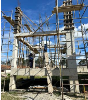
RESERVATÓRIO ELEVADO: ESTRUTURA
