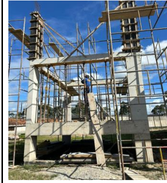
RESERVATÓRIO ELEVADO: ESTRUTURA
