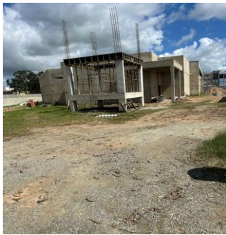
RESERVATÓRIO ELEVADO: ESTRUTURA
