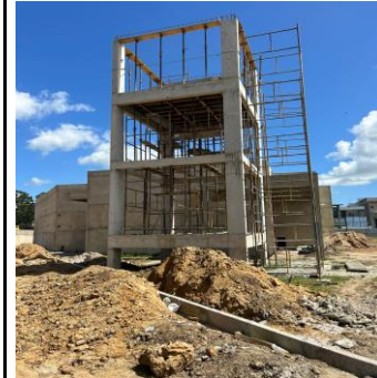
RESERVATÓRIO ELEVADO: ESTRUTURA
