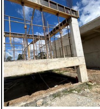
RESERVATÓRIO ELEVADO: ESTRUTURA
