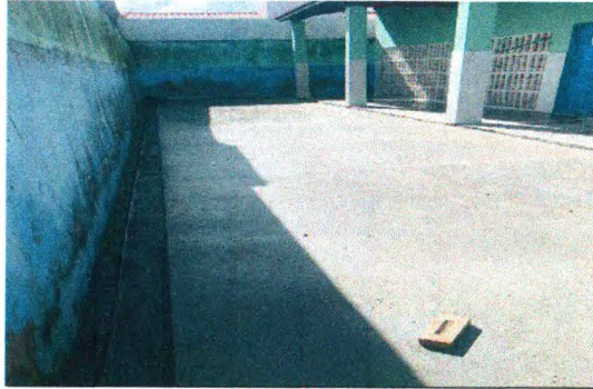
PISO EM CONCRETO
