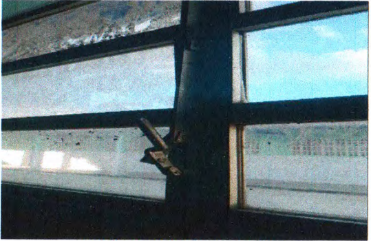
REVISÃO DE ESQUADRIA DE ALUMÍNIO
