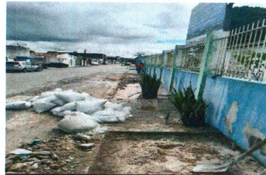
DEMOLIÇÃO MANUAL DE PISO
