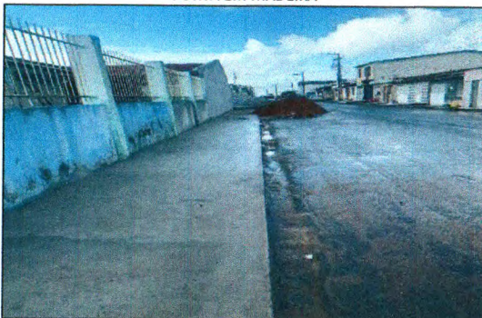
PISO EM CONCRETO
