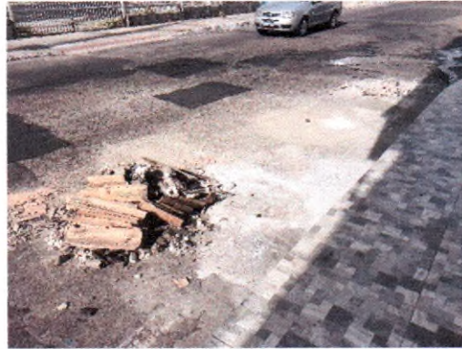
RUA JOSÉ FERREIRA DE ARAÚJO
