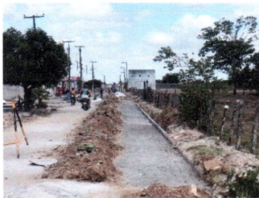
AVENIDA PADRE AIRTON GONÇALVES
