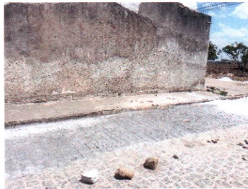
AVENIDA PADRE AIRTON GONÇALVES
