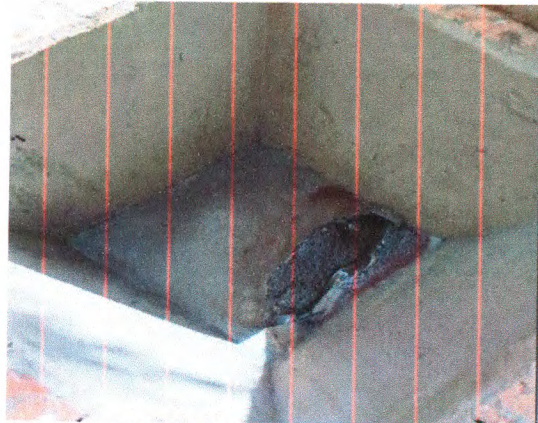
LIMPEZA DE CAIXA DE GORDURA
