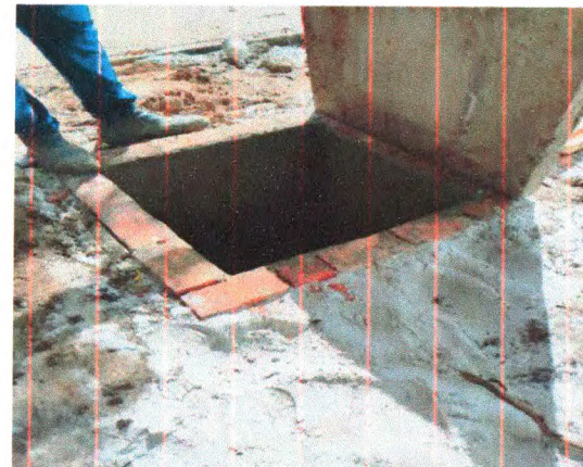
REVISÃO DE PONTO DE ESGOTO
