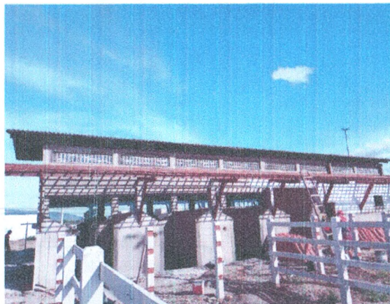
BAIAS DESCOBERTAS - CERCA DE MADEIRA PARA CURRAL EM MOURÕES DE PIQUI; PINTURA ESMALTE SOBRE MADEIRA
