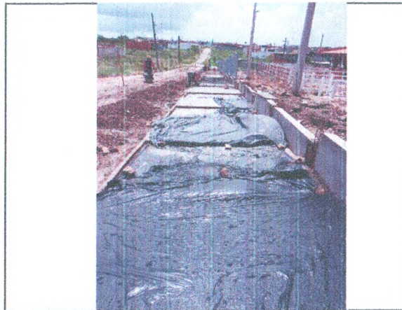
ASSENTAMENTO DE MEIO-FIO; LONA PLÁSTICA; PISO EM CONCRETO DESEMPOLADO; MURETA EM
