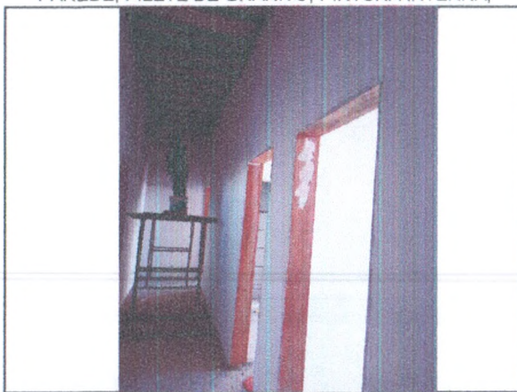
ADMINISTRAÇÃO - PINTURA DE PAREDES; CAIXÃO DAS PORTAS
