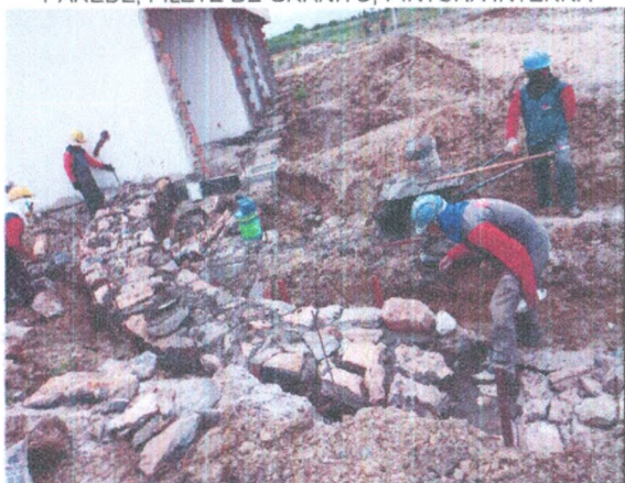
GALPÃO PRÉ-MOLDADO - FUNDAÇÃO; ALVENARIA DE PEDRA ARGAMASSADA
