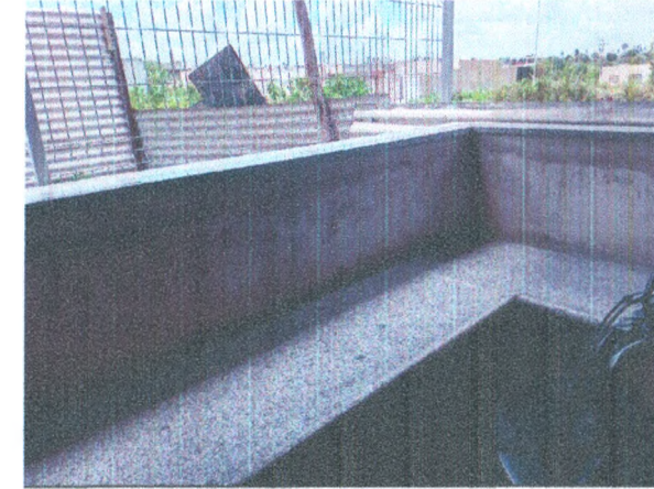
GUARITA - TAMPO DE GRANITO
