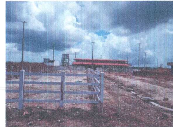
BAIAS DESCOBERTAS - CERCA DE MADEIRA PARA CURRAL EM MOURÕES DE PIQUI; PINTURA ESMALTE SOBRE MADEIRA
