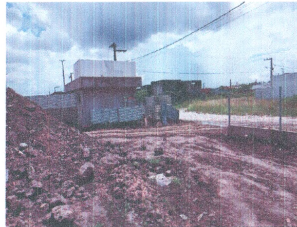
REGULARIZAÇÃO DO TERRENO
