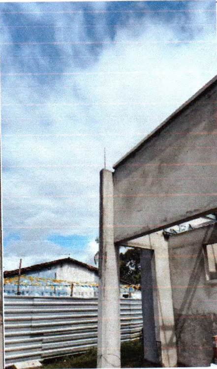
Figura 32: Haste de aterramento 5/8 para SPDA
