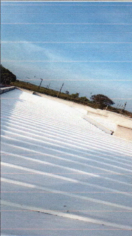
Figura 10: Telhamento com telha em aço galvanizado
