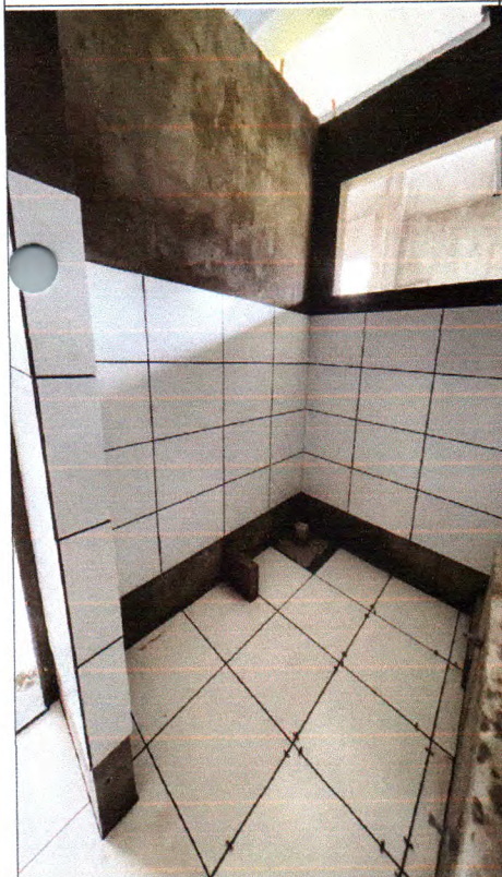
Figura 16: Revestimento cerâmico para paredes internas com placas tipo esmaltada extra de dimensões 33x45cm
