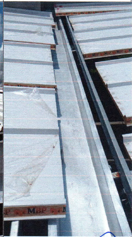
Figura 12: Calha em chapa de aço galvanizado
