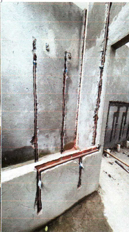
Figura 29: Instalação Hidráulica - Tubulação e conexões
