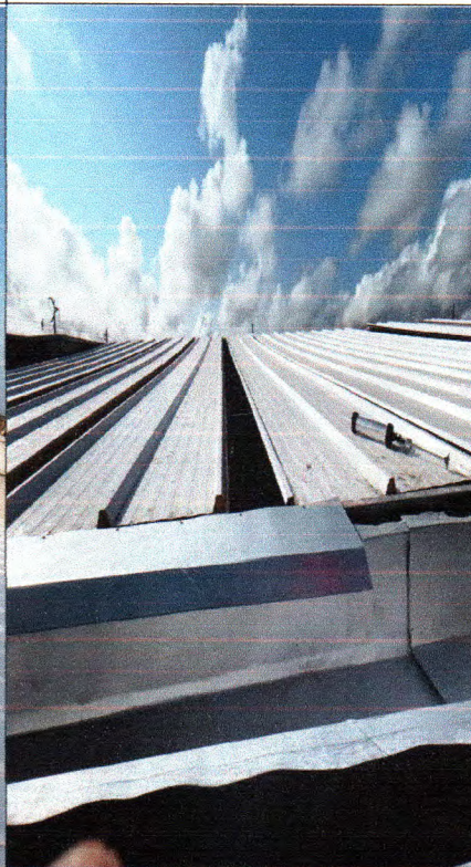
Figura 11: Rufo em chapa de aço galvanizado
