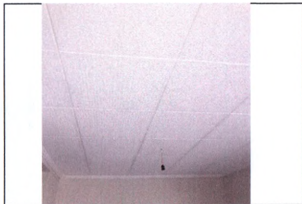
INSTALAÇÃO DE FORRO EM GESSO
