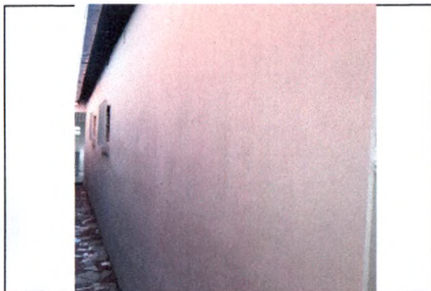
REBOCO, EMASSAMENTO E PINTURA EM PAREDE
