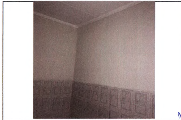
INSTALAÇÃO DE FORRO EM GESSO
