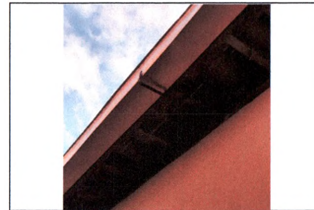
REVISÃO EM TELHADO COM SUBSTITUIÇÃO DE MATERIAL
