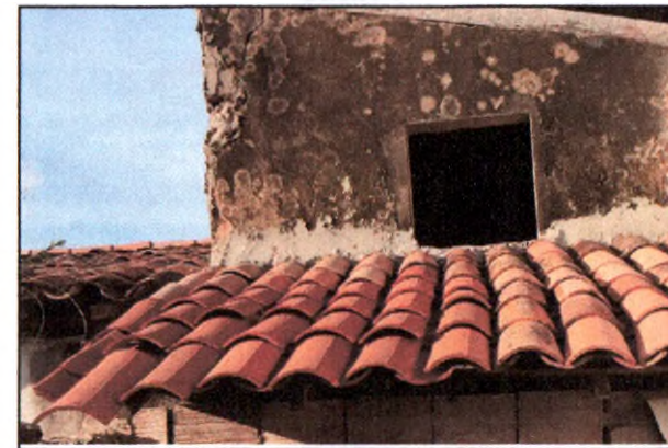
REVISÃO EM TELHADO COM SUBSTITUIÇÃO DE MATERIAL
