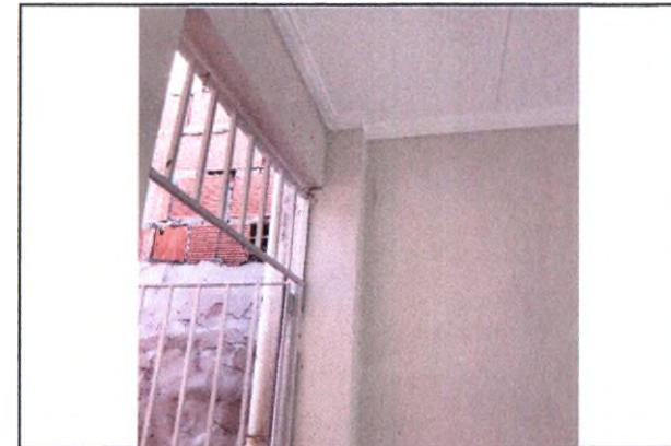
EMASSAMENTO E PINTURA EM PAREDE E PINTURA EM GRADE METÁLICA
