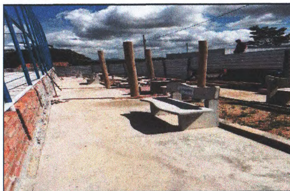
ALVENARIA DE VEDAÇÃO
