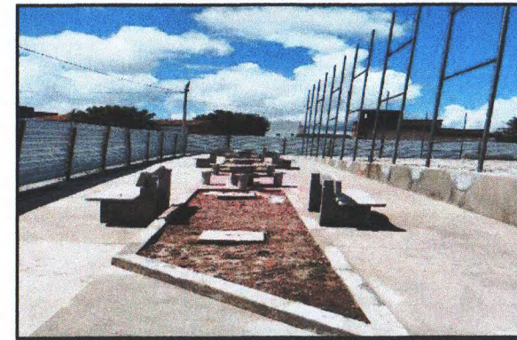
PISO EM CONCRETO
